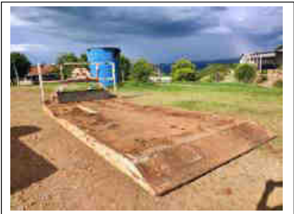
PRANCHA METÁLICA BUSA – SN11
