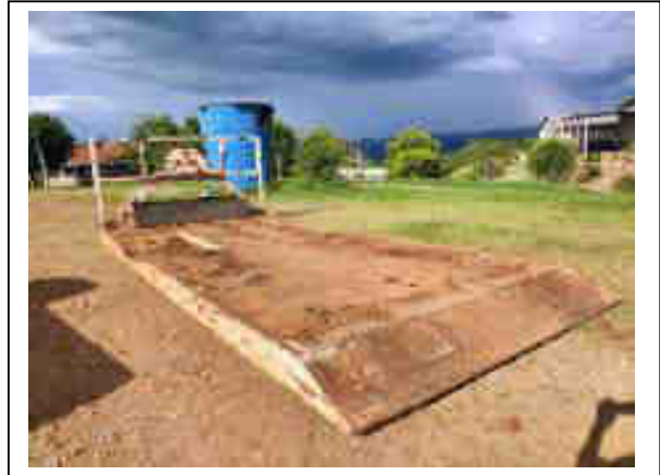
PRANCHA METÁLICA BUSA – SN11
