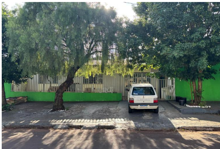
Figura 1 - Fachada da Rua Epitácio Pessoa, n.º 52, Parque São Paulo - Cascavel/PR
