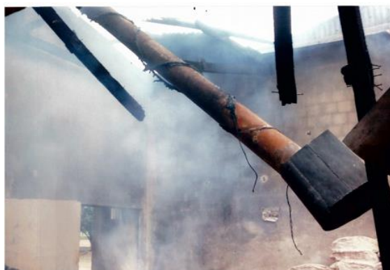
Incêndio da Fábrica de Ração da Granja.
