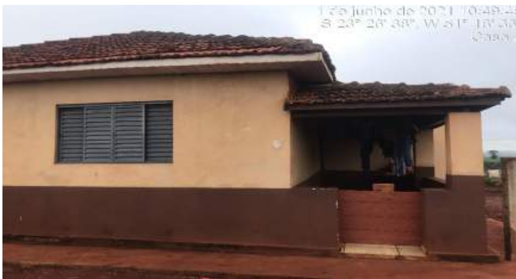
Figura 25: Casa 02 - Colônia Principal
