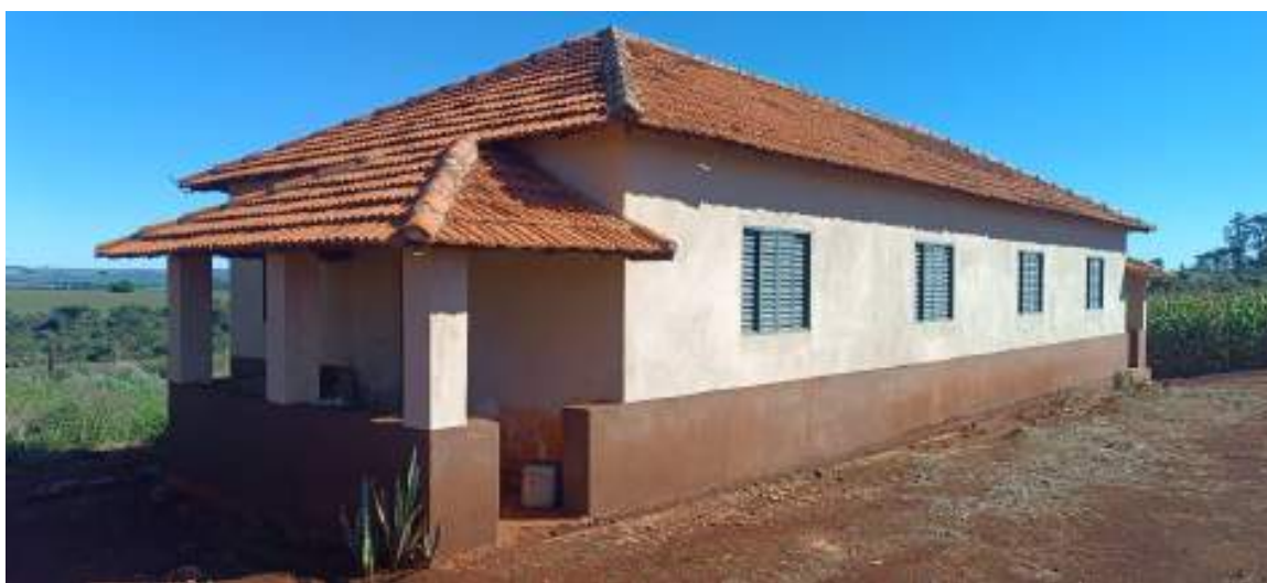
Figura 17: Casa 10 - Colônia Principal
