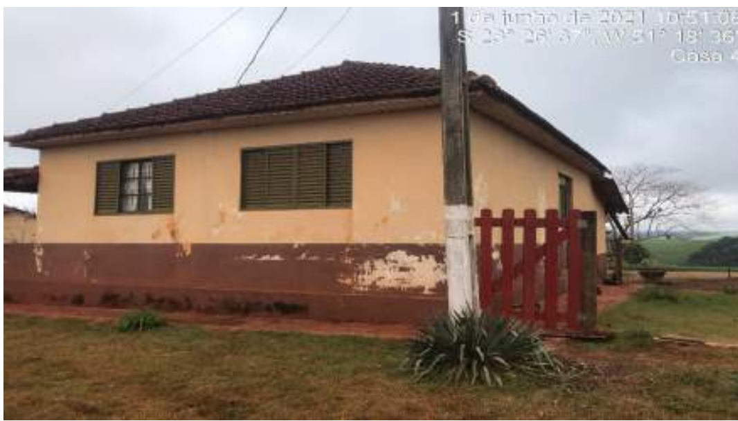
Figura 23: Casa 04 - Colônia Principal
