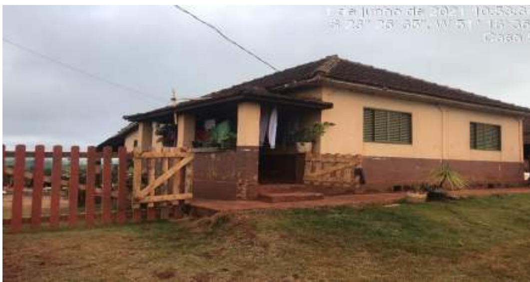
Figura 22: Casa 05 - Colônia Principal
