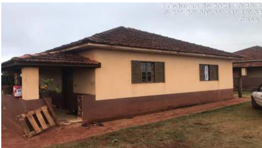
Figura 26: Casa 01 - Colônia Principal
