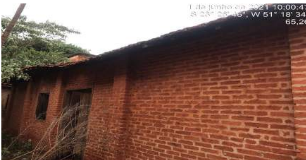
Figura 52: Barracão sem uso
