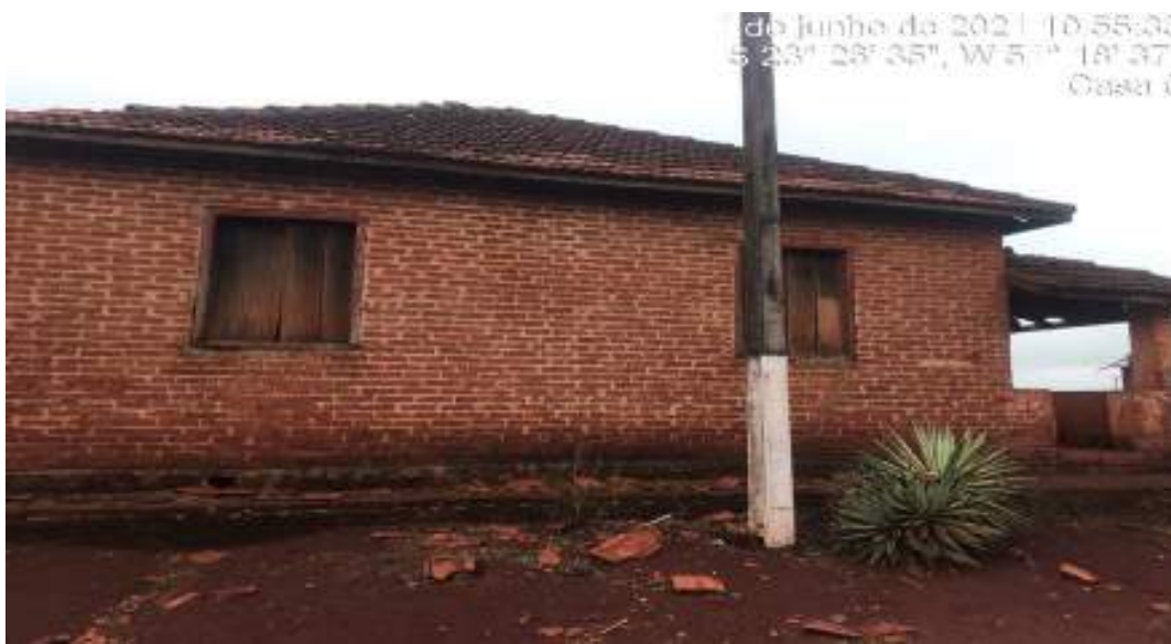
Figura 21: Casa 06 - Colônia Principal
