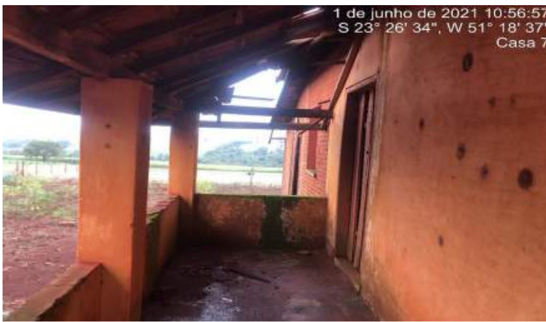
Figura 20: Casa 07 - Colônia Principal
