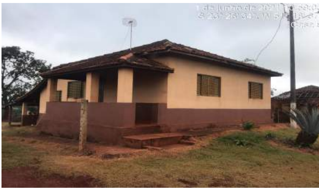
Figura 18: Casa 09 - Colônia Principal
