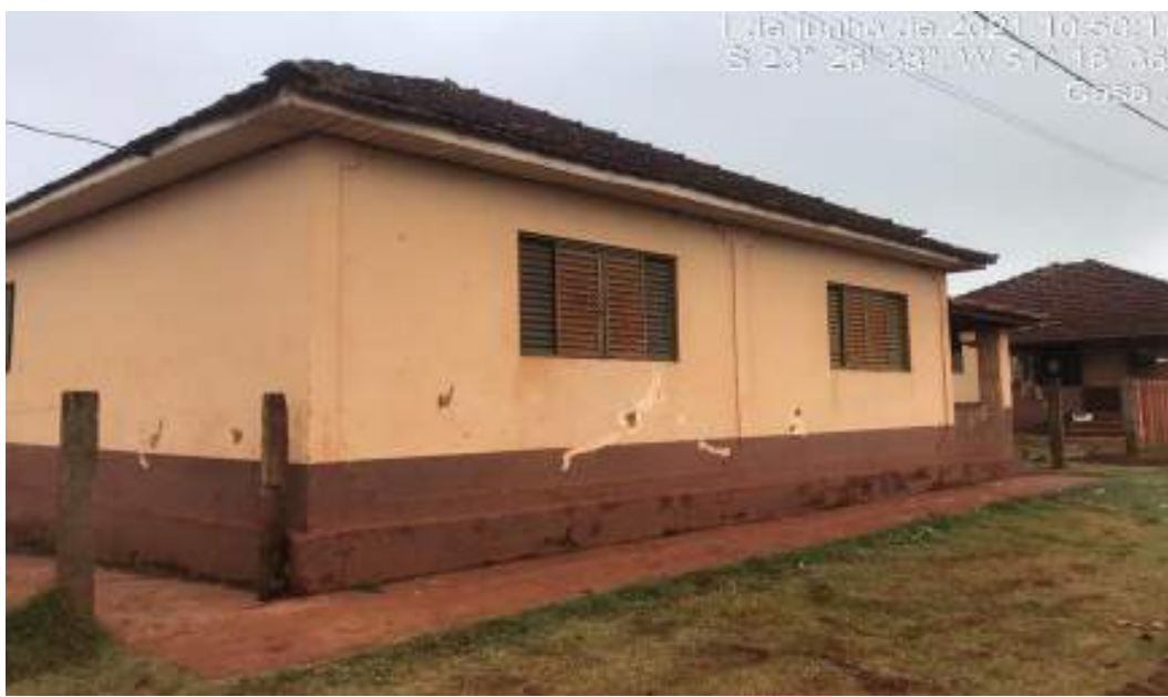
Figura 24: Casa 03 - Colônia Principal
