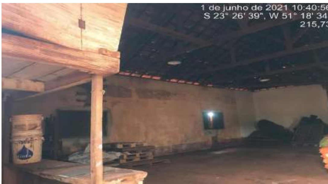
Figura 37: Barracão antigo cinema
