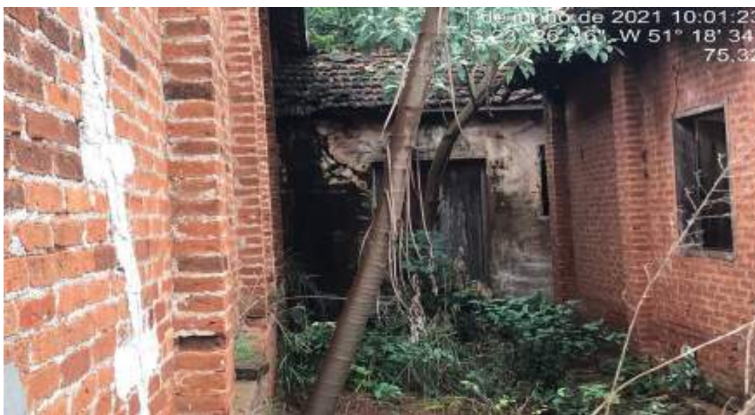
Figura 53: Barracão sem uso
