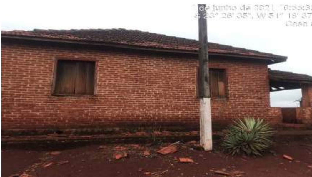
Figura 19: Casa 08 - Colônia Principal
