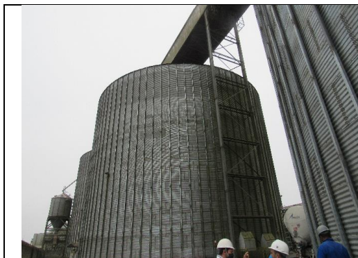
Silos de armazenagem
