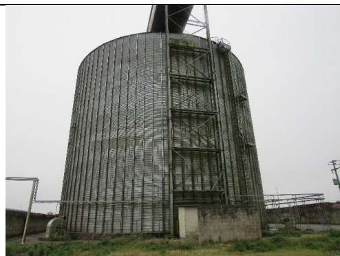
Silos de armazenagem
