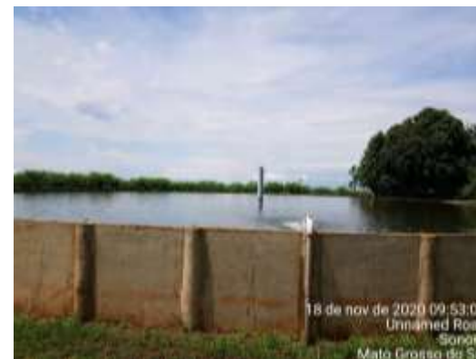
Reservatório de água
