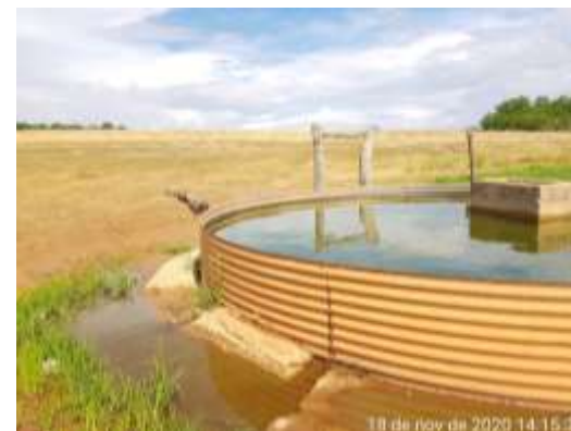
Reservatório de água
