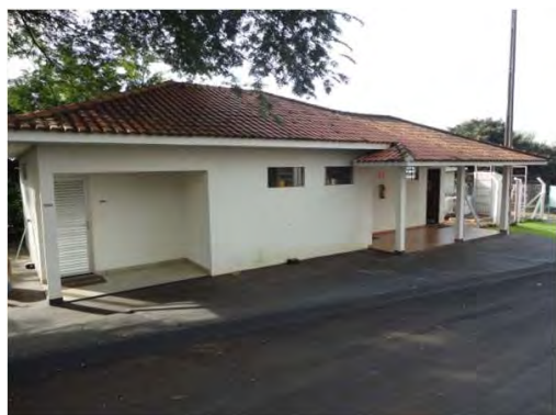
Vestibário das fábricas de Ibioporã
