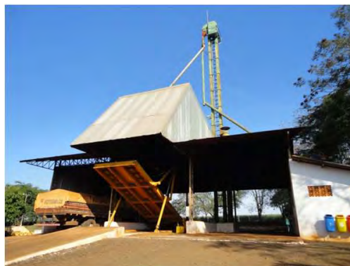
Estrutura da unidade
