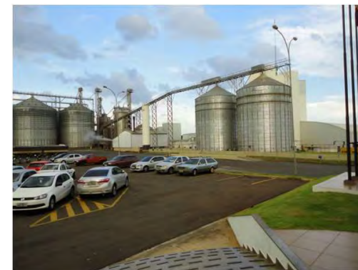
Silos de armazenagem de matéria prima a esquerda e atrás a fábrica
