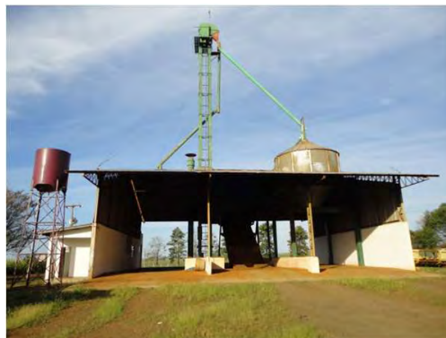
Estrutura da unidade
