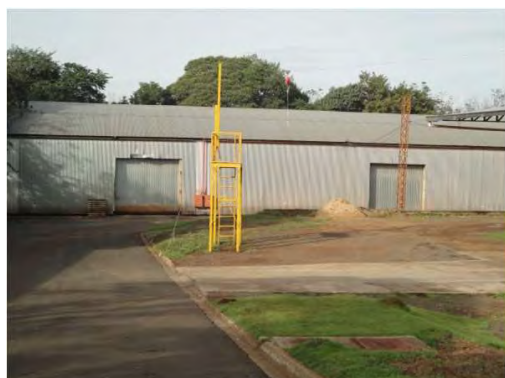
Galpão de resíduos
