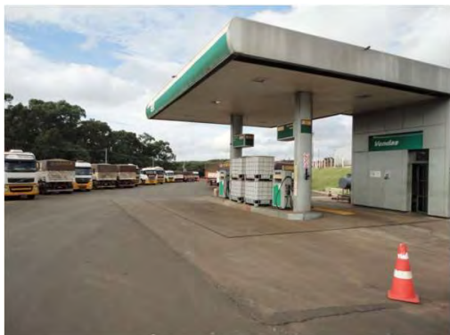
Fotos do posto de combustível
