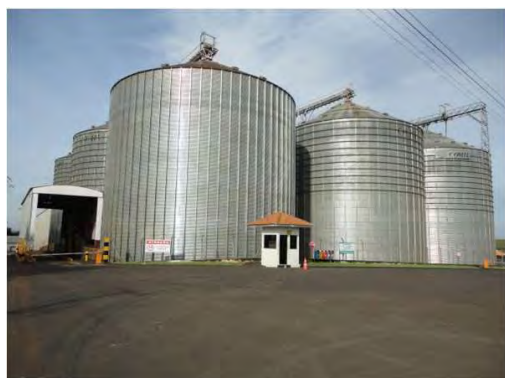
Estrutura física da unidade de recebimento de grãos
