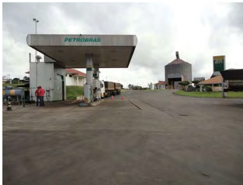
Fotos do posto de combustível
