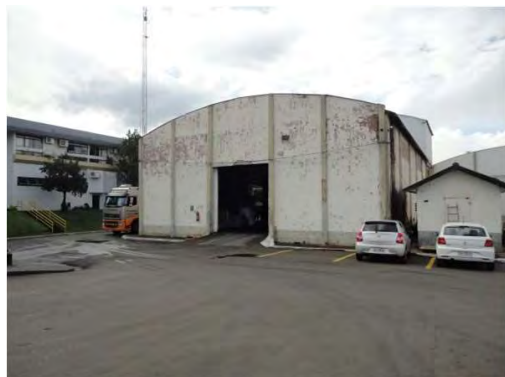
Estrutura física da indústria de empacotamento de açúcar
