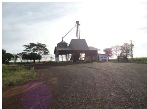
Estrutura da unidade de transbordo
