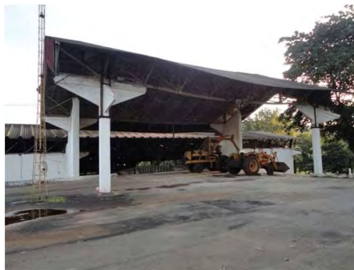
Estrutura da unidade
