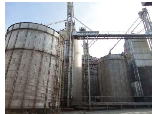
Silo pulmão e secadores de grãos
