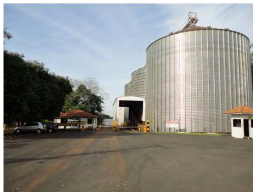
Estrutura física da unidade de recebimento de grãos
