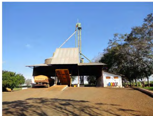
Estrutura da unidade
