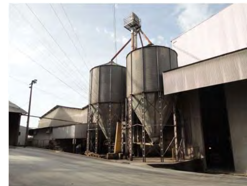
Silos de armazenagem de matéria prima
