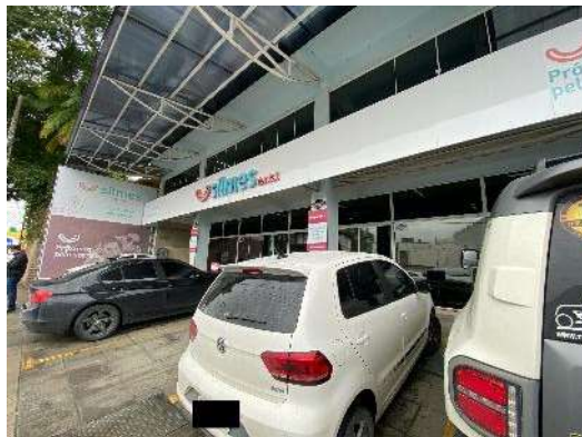
Área Externa / Estacionamento
