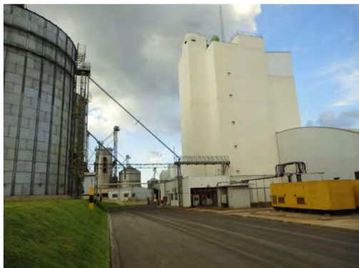
Fotos da estrutura da fábrica
