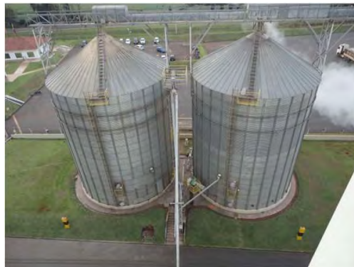
Silos de armazenagem de matéria prima
