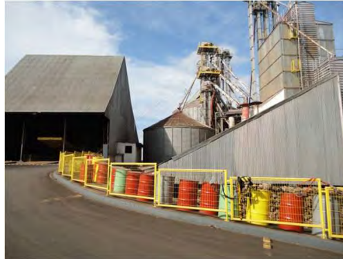
Moega silo pulmão e secador de grãos
