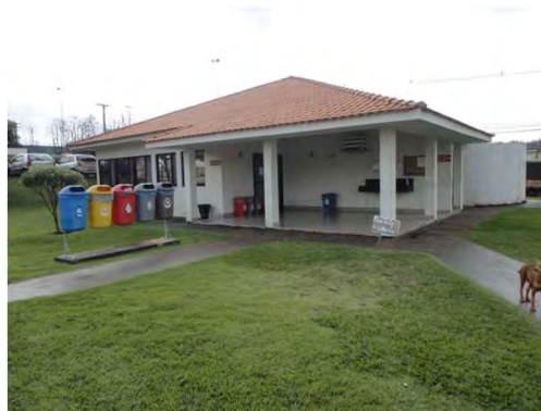
Refeitório – Foto Externa
