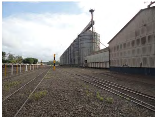
Pátio para manobras dos vagões e silos de armazenagem
