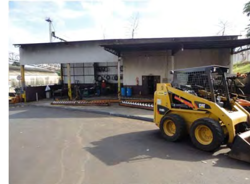
Oficina de manutenção
