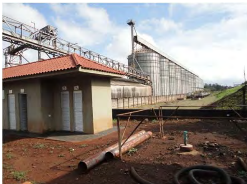
Silos de armazenagem
