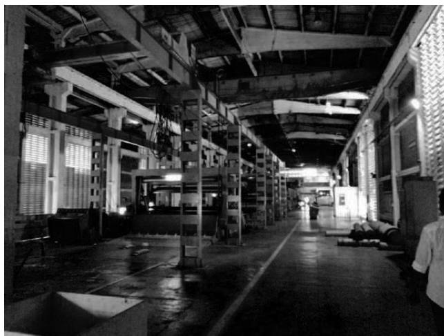
GALPÃO DE APARAS E MÁQUINA DE PAPEL ASPECTO INTERNO
