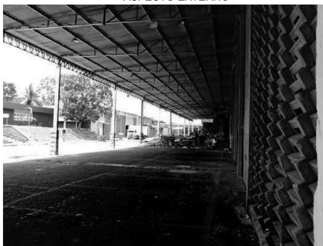
GALPÃO DE APARAS E MÁQUINA DE PAPEL ASPECTO EXTERNO
