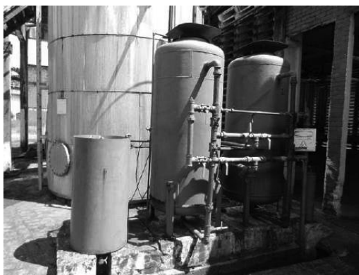
SISTEMA DE ABRANDAMENTO
