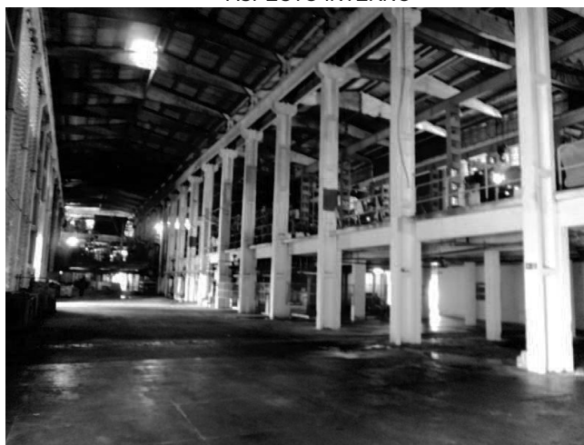
GALPÃO DE APARAS E MÁQUINA DE PAPEL ASPECTO INTERNO
