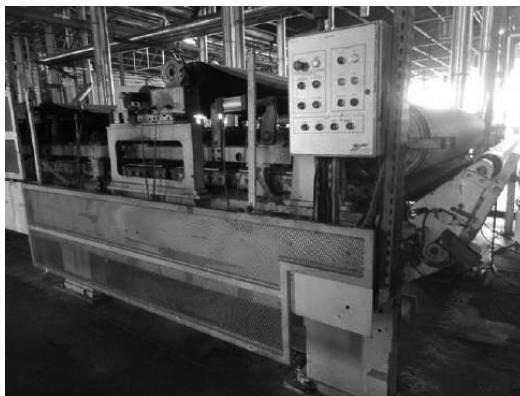
NR 1244 - MESA DE SECAGEM DA ONDULADEIRA TOMASONI
