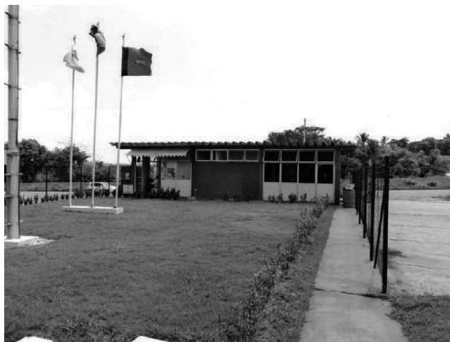
PORTARIA ASPECTO EXTERNO
