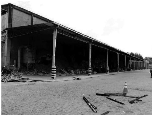
GALPÃO DE APARAS E MÁQUINA DE PAPEL ASPECTO EXTERNO
