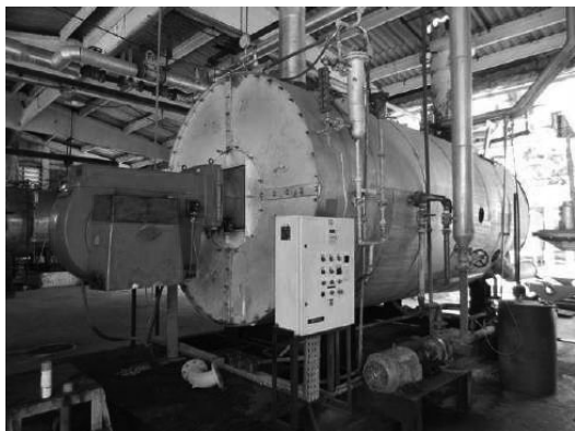
NR 1215 - CALDEIRA DE VAPOR A ÓLEO CAP: 8.000 kg/h POWER MASTER
