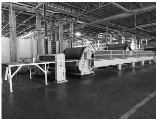
NR 1244 - MESA DE SECAGEM DA ONDULADEIRA TOMASONI
