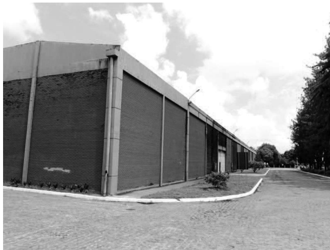
FÁBRICA DE SACOS ASPECTO EXTERNO
