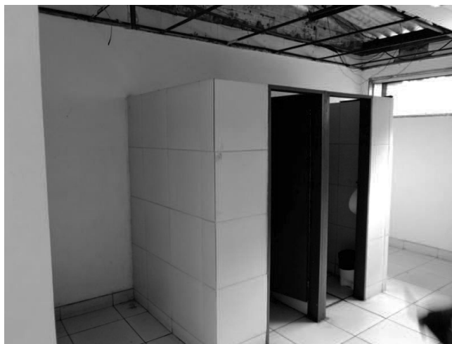
VESTIÁRIOS E SANITÁRIOS DOS FUNCIONÁRIOS ASPECTO INTERNO
