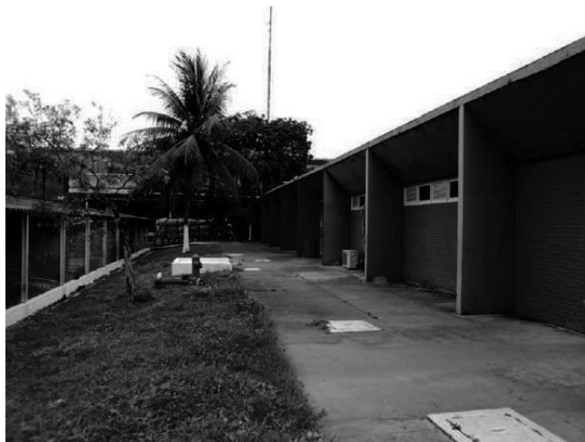
REFEITÓRIO, AMBULATÓRIO E ÁREA DESATIVADA ASPECTO EXTERNO
