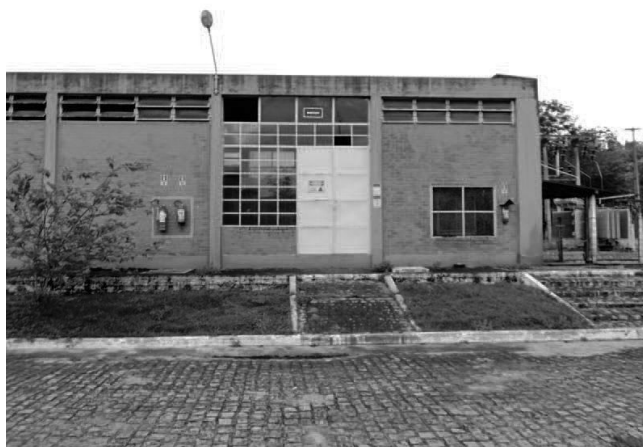
SUBESTAÇÃO 02 ASPECTO EXTERNO
