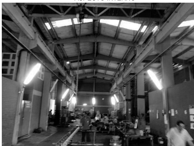
OFICINA, ALMOXARIFADO E SUCATAS ASPECTO INTERNO
