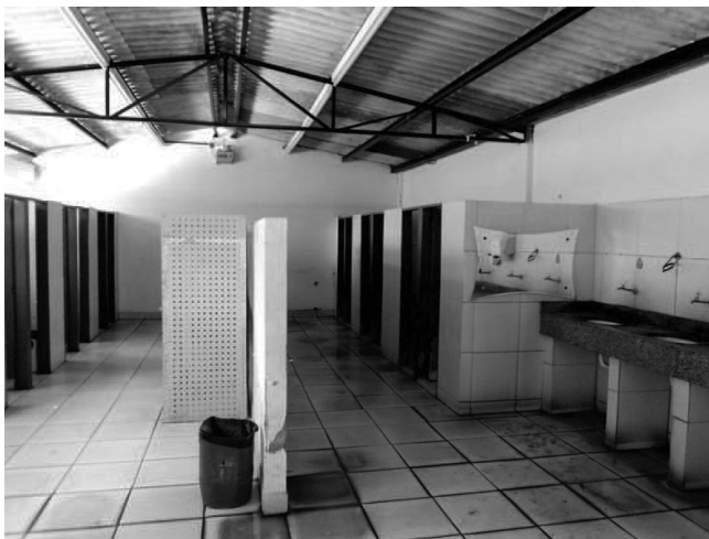
VESTIÁRIOS E SANITÁRIOS DOS FUNCIONÁRIOS ASPECTO INTERNO
