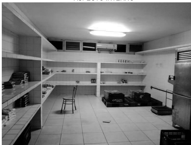
REFEITÓRIO, AMBULATÓRIO E ÁREA DESATIVADA ASPECTO INTERNO
