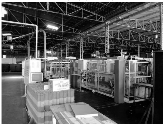
IMPRESSORAS ASPECTO INTERNO
