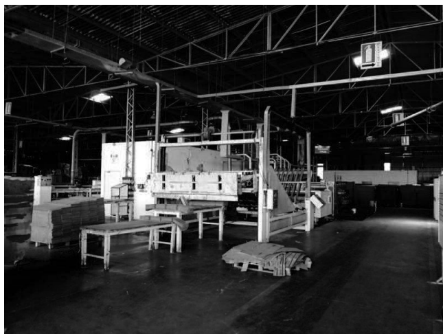
IMPRESSORAS ASPECTO INTERNO
