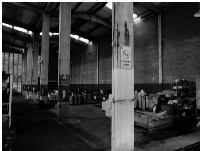
OFICINA, ALMOXARIFADO E SUCATAS ASPECTO INTERNO
