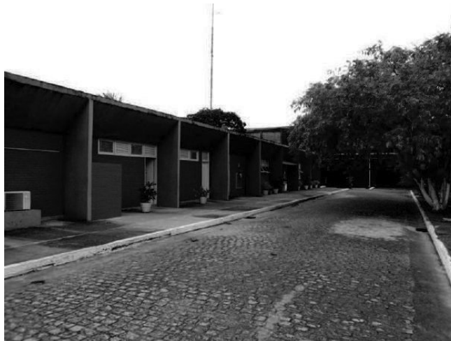
REFEITÓRIO, AMBULATÓRIO E ÁREA DESATIVADA ASPECTO EXTERNO
