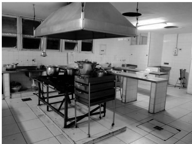
REFEITÓRIO, AMBULATÓRIO E ÁREA DESATIVADA ASPECTO INTERNO
