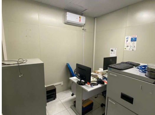
Sala de TI e Servidor
