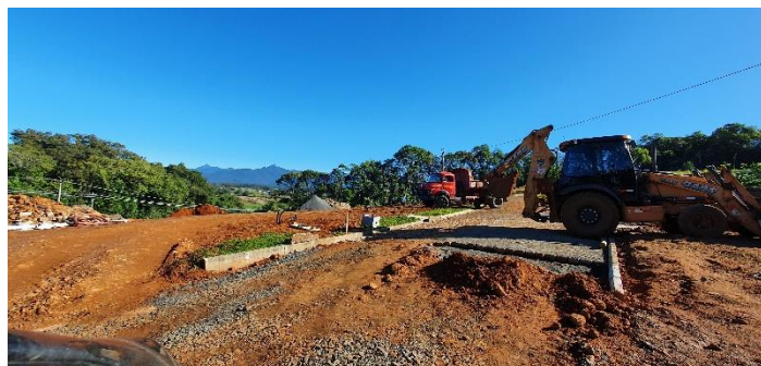
Canteiro de obras (condomínio)
