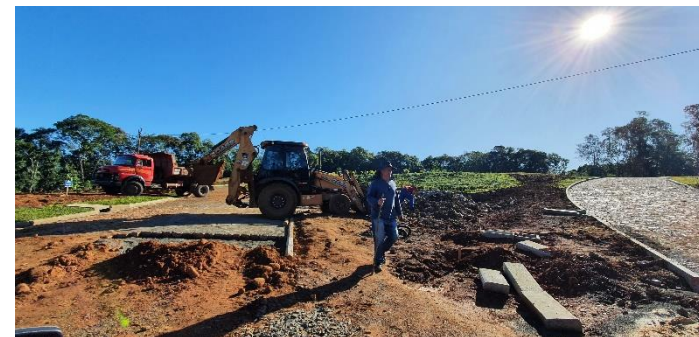
Canteiro de obras (condomínio)
