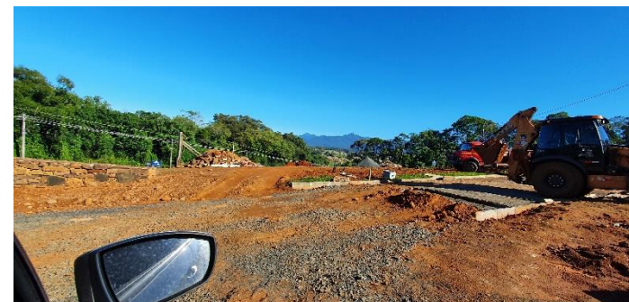
Canteiro de obras (condomínio)
