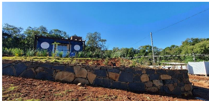
Canteiro de obras (condomínio)
