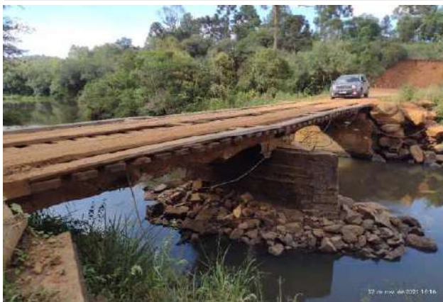
Ponte de acesso ao imóvel
