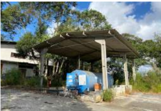
Cobertura do Tanque de Combustível
