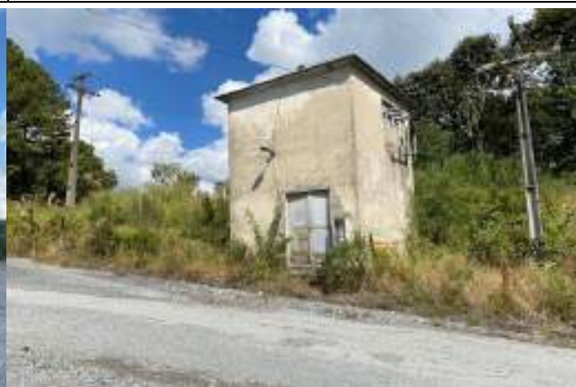
Sala do Transformador
