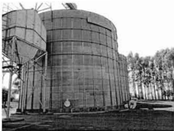
2.4.2- Modelo KW ( KeplerWeber ) 3608 / com diâmetro: 10,90 metros capacidade total de 600 toneladas cada ( 01 unidade );
