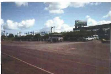
1.3.1.2.6. Contra-piso em concreto alisado / redor dos silos / regular estado de conservação e manutenção, idade aparente de 05 ( cinco ) anos, não apresentando visivelmente qualquer patologia ( 1.640,00 m 2 );
