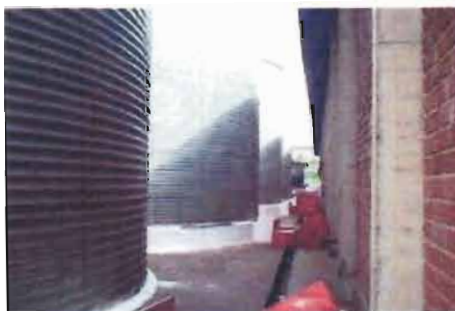
1.3.1.2.6. Contra-piso em concreto alisado / redor dos silos / regular estado de conservação e manutenção, idade aparente de 05 ( cinco ) anos, não apresentando visivelmente qualquer patologia ( 1.640,00 m 2 );
