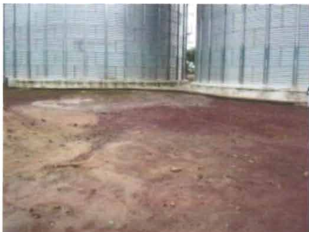
4.4.2 - Modelo KW ( KeplerWeber ) 3608 / diâmetro: 10,90 metros capacidade de 600 toneladas cada ( 01 unidade );
