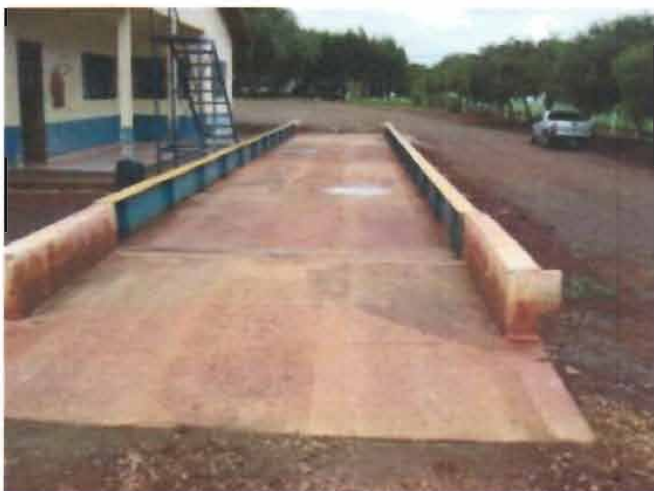
4.5 - Balança em concreto estrutural com 20,00m x 4,00m, caixa enterrada em concreto com 1,40m de profundidade, rede de drenagem de águas pluviais.
