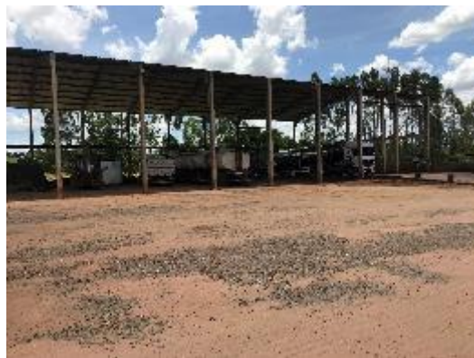
Local de lavagem dos tanques dos caminhões
