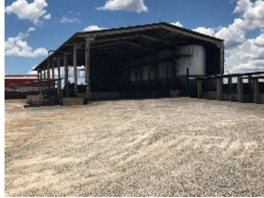
Barracão de descarga e armazenamento de matéria prima e produto acabado
