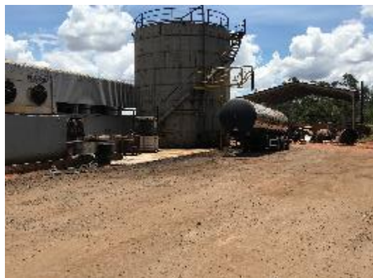
Silo de estocagem de matéria prima
