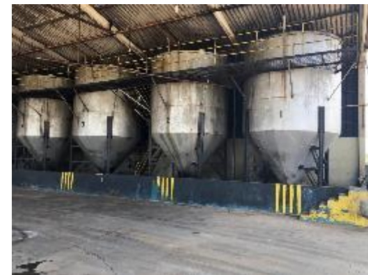
Silos com produtos acabados
