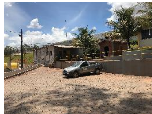
Almoxarifado de peças de manutenção e reposição
