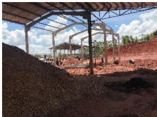
Barracão para instalação da novca caldeira
