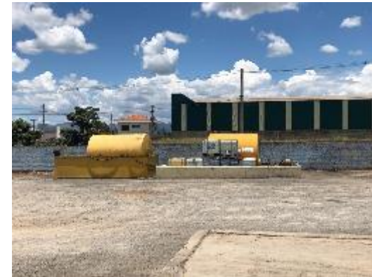
Tanque de combustível e balança
