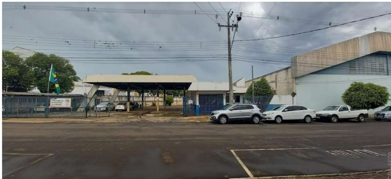
Figura 1: Fachada MATRIZ PATO BRANCO-PR.
