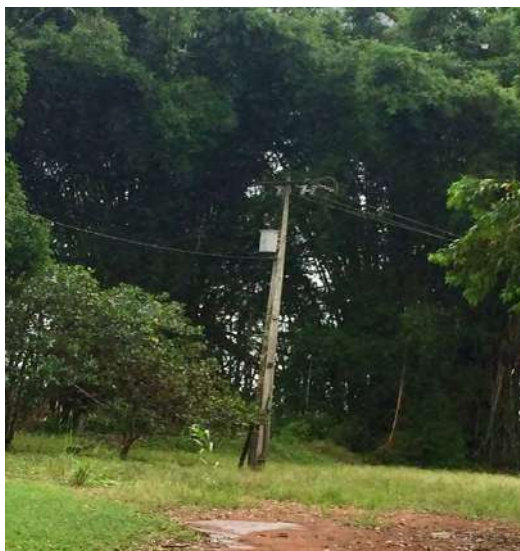
Fazenda São Vicente - Poço artesiano – Juscimeira – MT – Transformador 45 Kva
