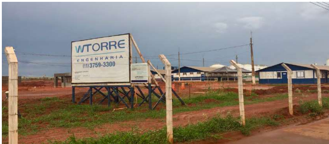
Figura 24- Rua A – A principal, Terminal de combustível- PETROBRAS
