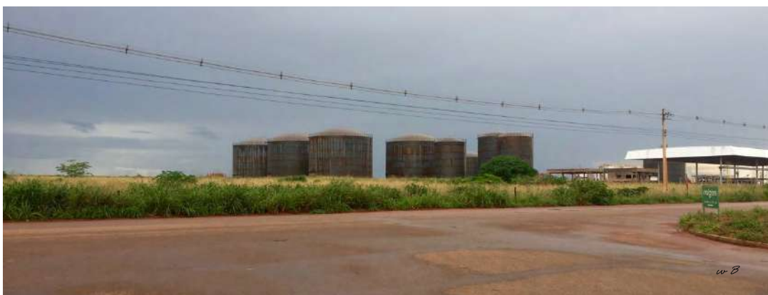
Figura 15 - Rua A – A principal do Terminal de combustíveis Petrobras em obras. Vizinho do lote avaliado
