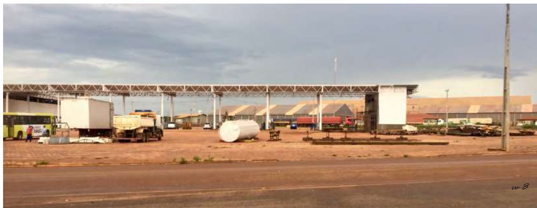
Figura 9 - Posto entrada do terminal
