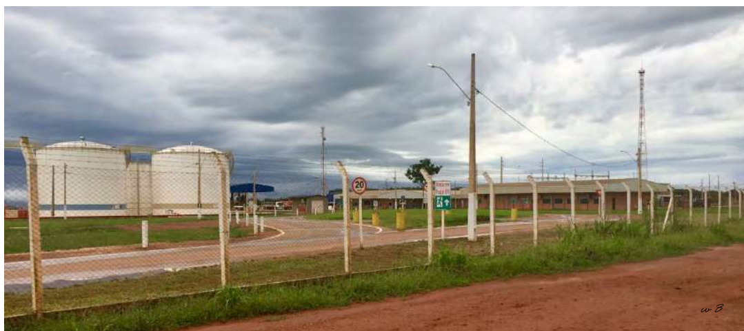
COFCO AGRI – armazenamento e moagem, tem capacidade de moagem 4.000 toneladas por dia.
