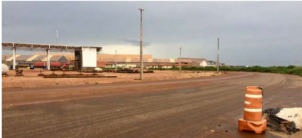
Figura 8 Posto entrada do Terminal
