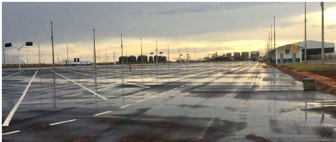
Figura 4 Pátio de estacionamento
