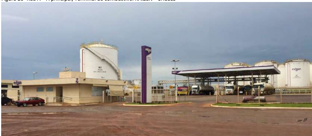
Figura 21- Rua A – A principal, Terminal de combustível RAÍZEN – SHEELL -
