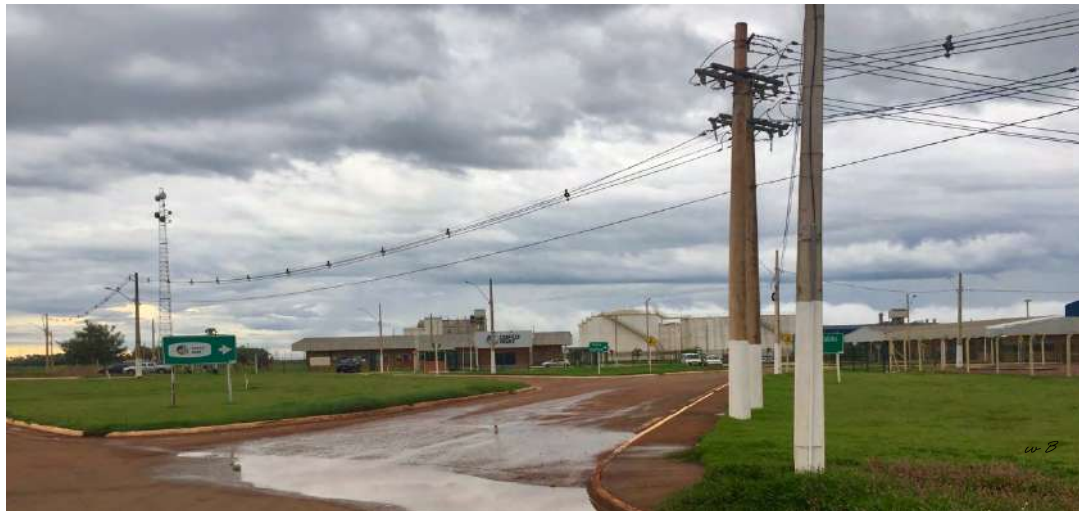
Figura 32- – Rua B – Marginal frente pra BR 163 – COFCO AGRI – armazenamento e moagem
