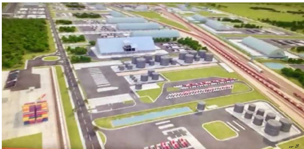
Vista em perspectiva do projeto do Parque Industrial de Rondonópolis, vista do fundo para frente.
