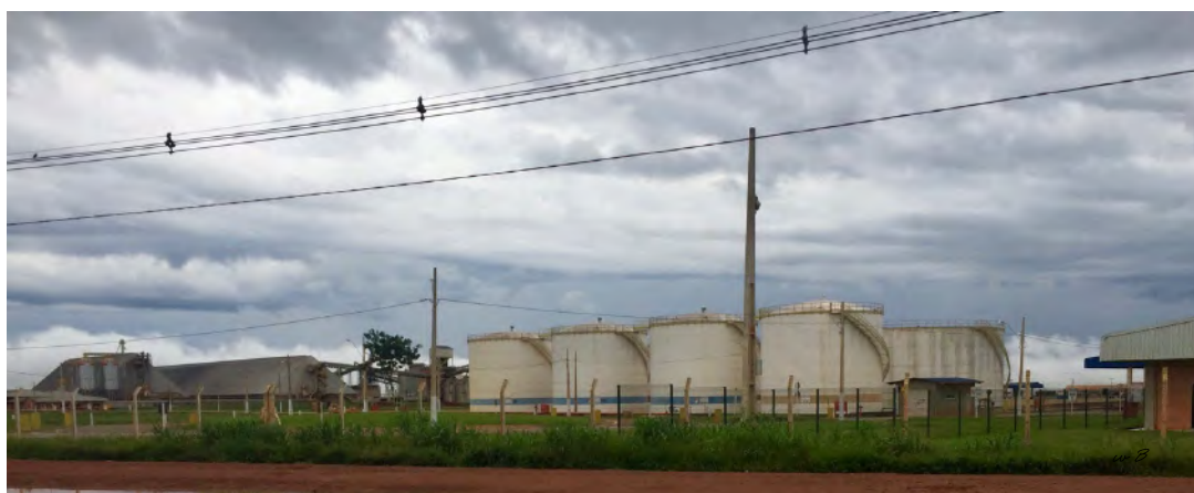
COFCO AGRI – armazenamento e 600 toneladas de produção em sua unidade de biodiesel.
