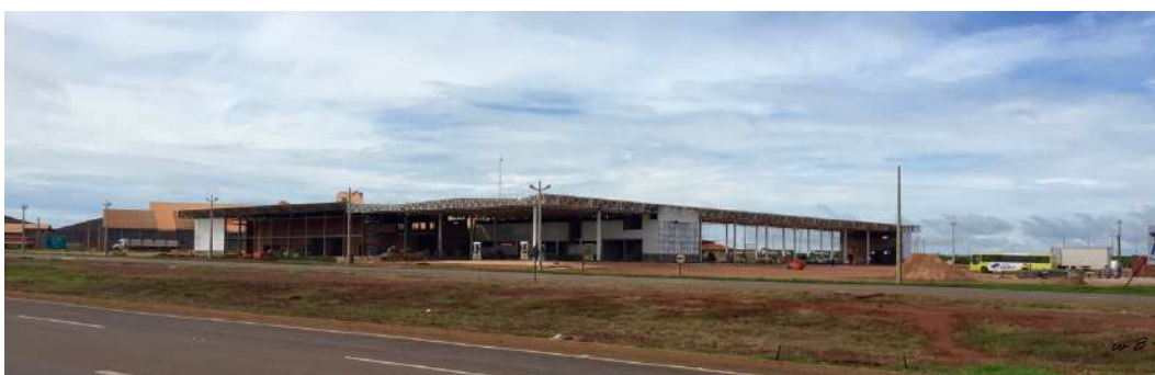
Figura 4 –Auto Posto na entrada do terminal, em construção.
