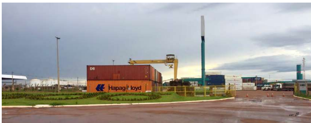
Figura 15 - Rua A – A principal, Terminal de Contêiner – Brado Logística.
