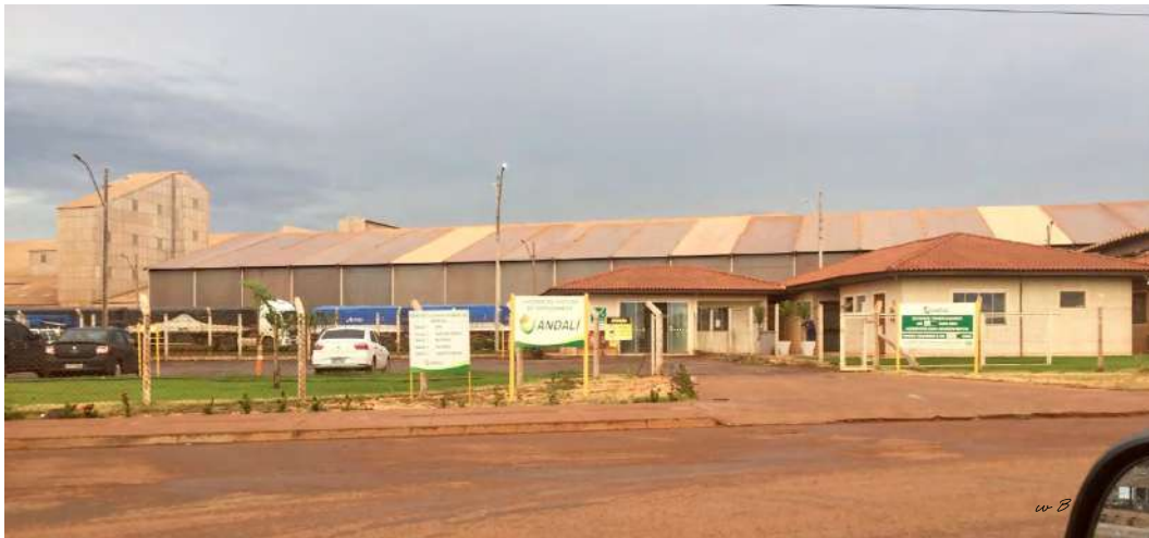
Figura 10 - ANDALI – Unidade de Fertilizantes entrada do terminal
