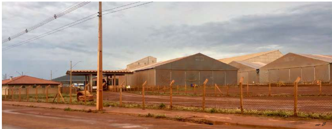
Figura 11 - ANDALI – Unidade de Fertilizantes entrada do terminal
