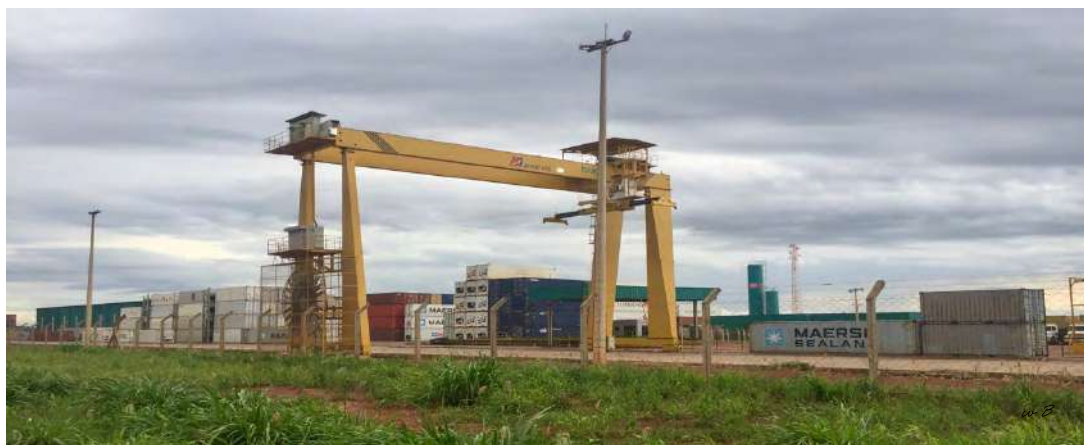
Figura 16 - Rua A – A principal, Terminal de Contêiner – Brado Logística.
