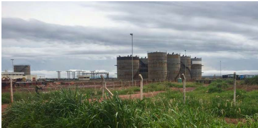
Figura 14 - Rua A principal do terminal, Ipiranga – terminal de combustível em obras
