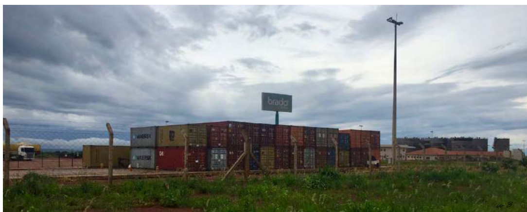
Figura 17- Rua A – A principal, Terminal de Contêiner – Brado Logística.
