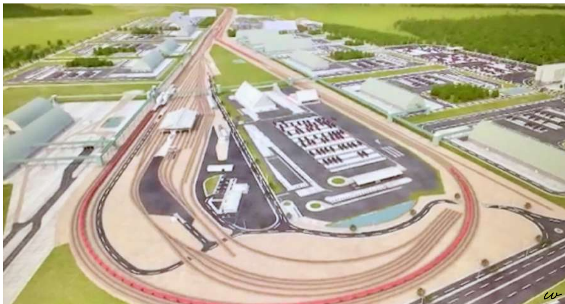
Vista em perspectiva do projeto do Parque Industrial de Rondonópolis - Vista de frente para fundo
