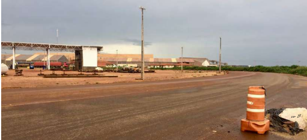
Figura 8 Posto entrada do Terminal
