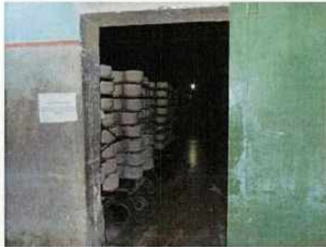
Figura 16 – Estufa com gerador de calor.
