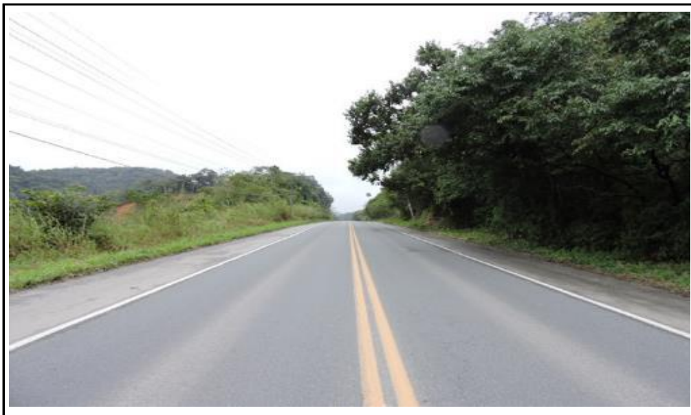
Aspecto da Rodovia Guilherme Jensem - SC 108, com Imóvel de ambos os lados
