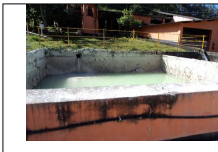
Processo de reciclagem de água
