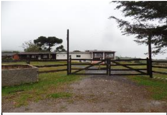
Aspecto das construções no entorno
