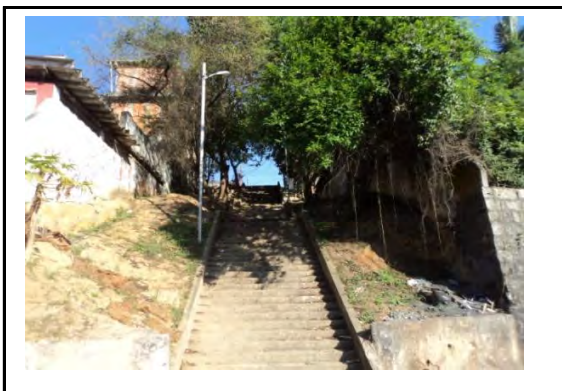
Escada acesso a rua de cima - avaliando lado direito
