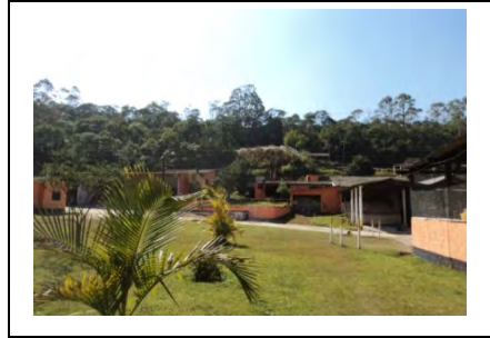
Edificações de apoio
