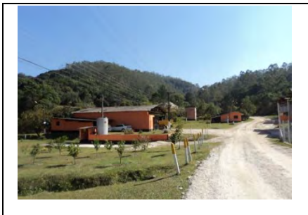
Edificações de apoio
