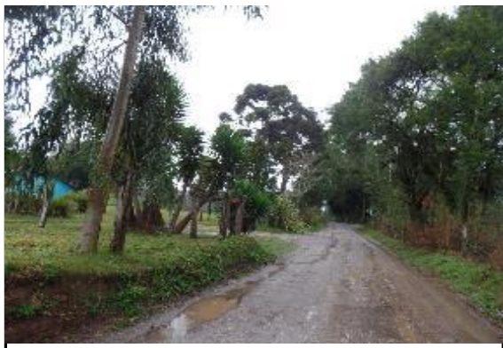
Aspecto da estrada na chegada do local
