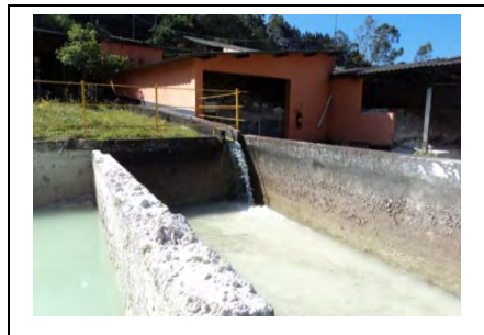
Processo de reciclagem de água
