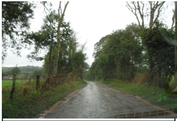
Detalhe da Estrada Sabina Risita
