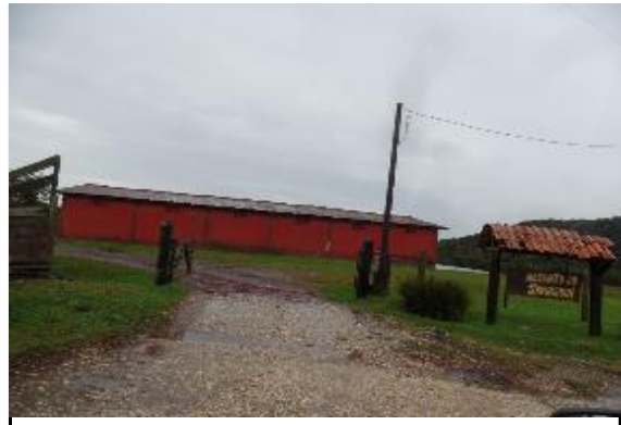
Aspecto das construções no entorno
