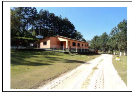
Edificações de apoio
