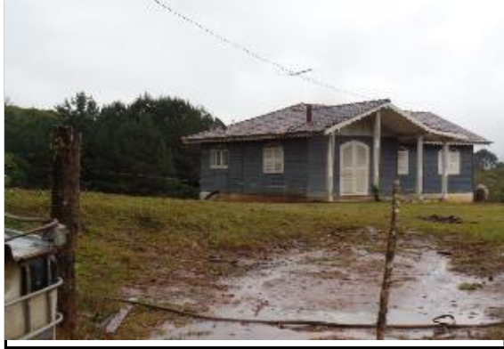
Aspecto das construções no entorno
