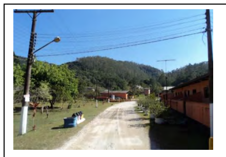
Edificações de apoio
