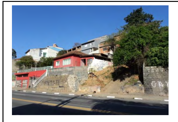
Imóvel vizinho do lado esquerdo após escada
