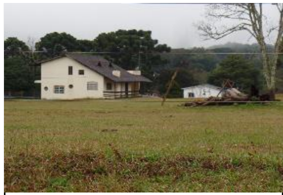
Aspecto das construções no entorno
