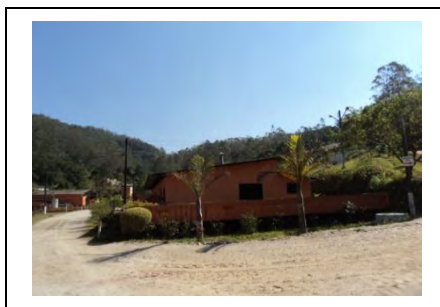
Edificações de apoio
