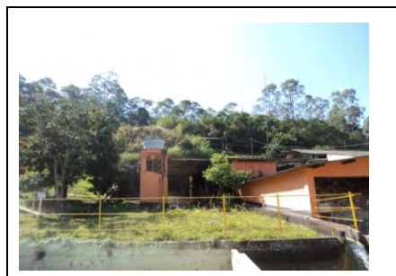
Processo de reciclagem de água
