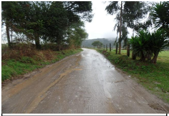
Detalhe da Estrada Sabina Risita
