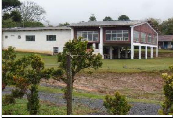
Aspecto das construções no entorno
