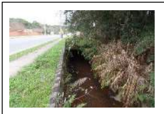
Detalhe da passagem subterrânea em frente ao imóvel
