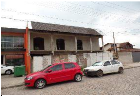
Residência em construção
