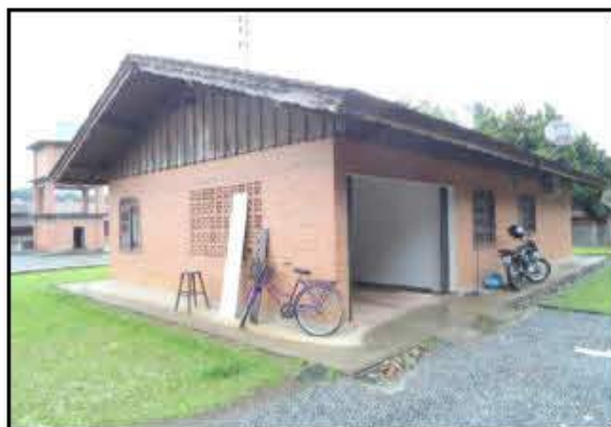
Fachada da residência
