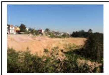
Obras emergenciais de Contenção
