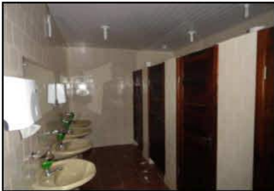
Detalhe de sanitário
