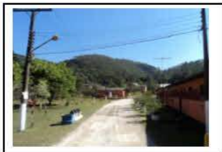
Edificações de apoio
