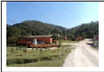
Edificações de apoio
