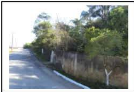
Muro de divisa
