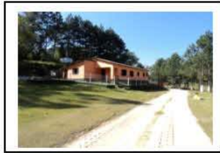
Edificações de apoio
