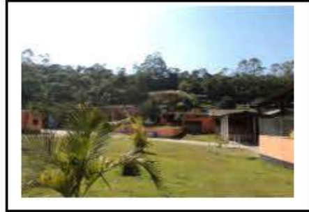
Edificações de apoio
