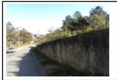
Muro de divisa
