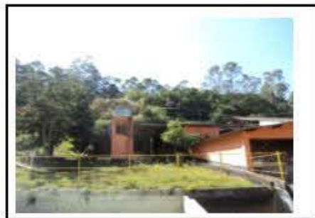
Processo de reciclagem de água
