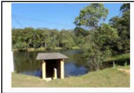
Represa de captação de água
