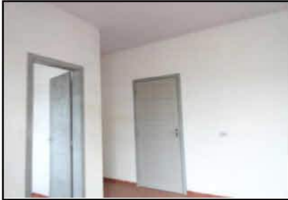
Vista interna da sala
