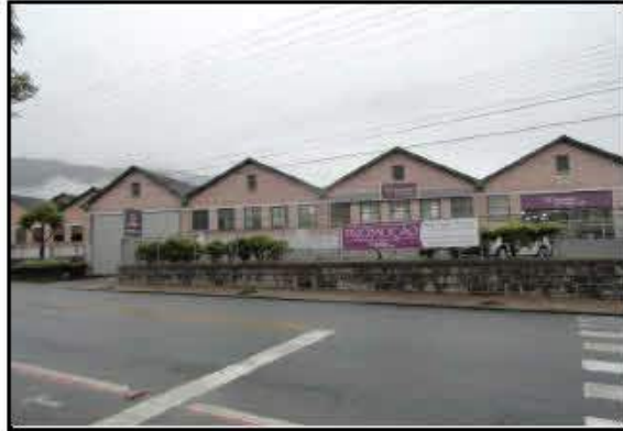
Outra vista da fachada principal
