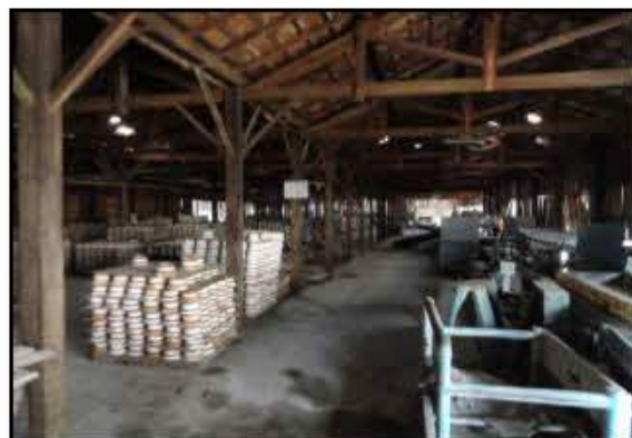
Vista interna de galpão de madeira
