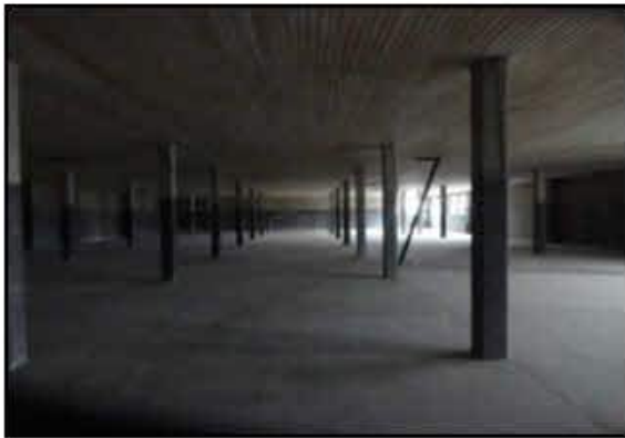
Vista do pavimento superior
