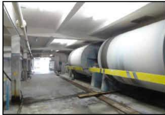
Detalhe do subsolo do galpão de decalque
