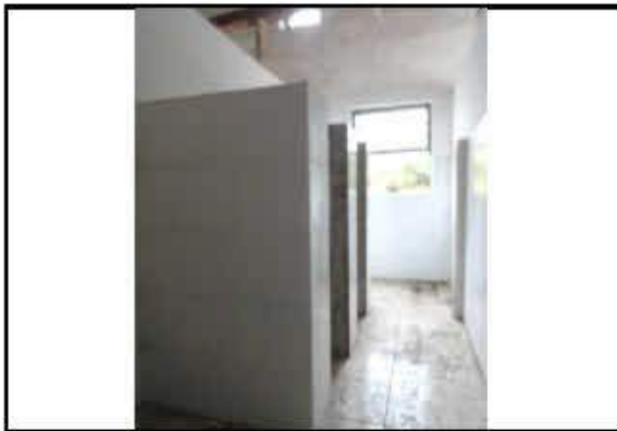
Vista de futuros sanitários
