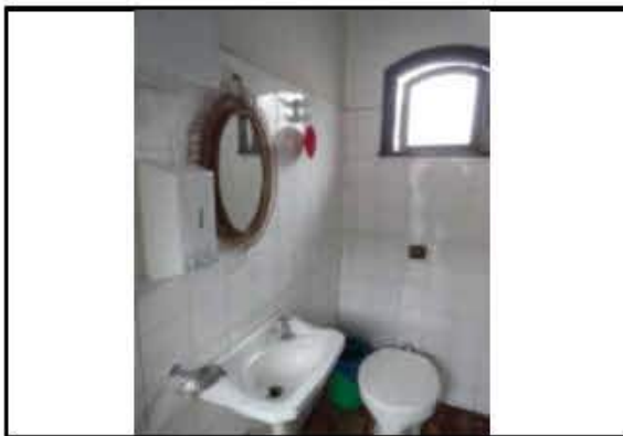
Detalhe de sanitário da portaria
