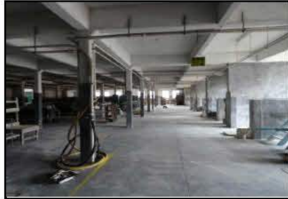
Pavimento térreo do galpão de decalque
