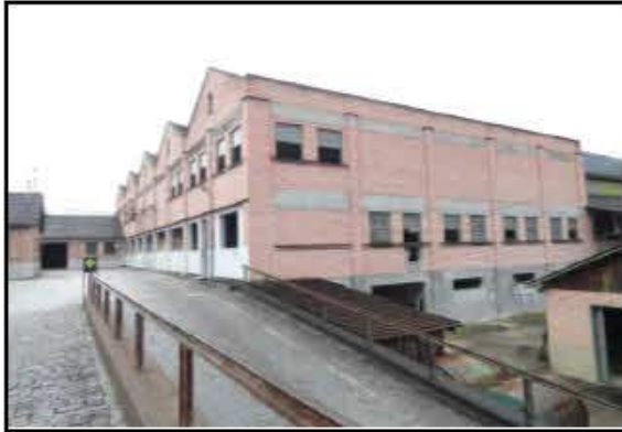
Galpão de decalque
