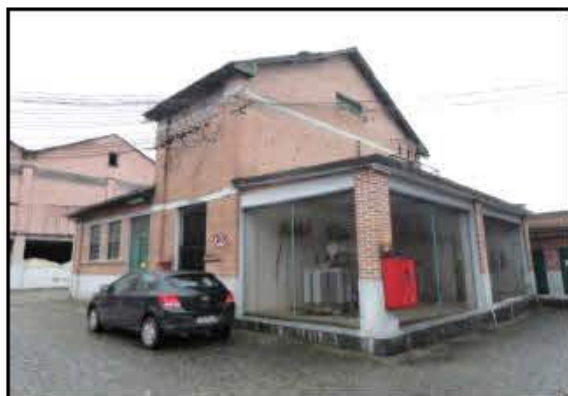
Aspecto da subestação
