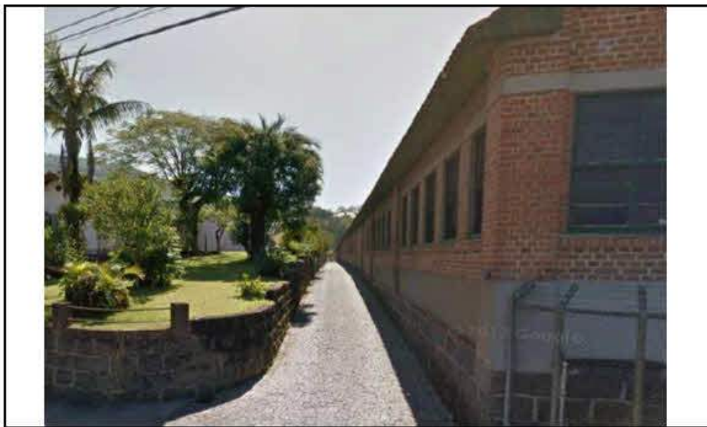
Aspecto da Rua Jaraguá, notando-se o imóvel à direita
