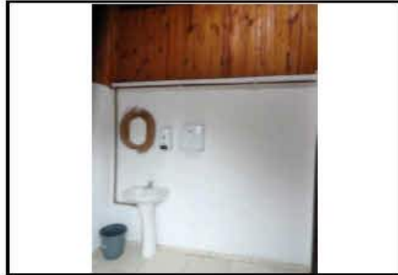
Detalhe de sanitário da cantina
