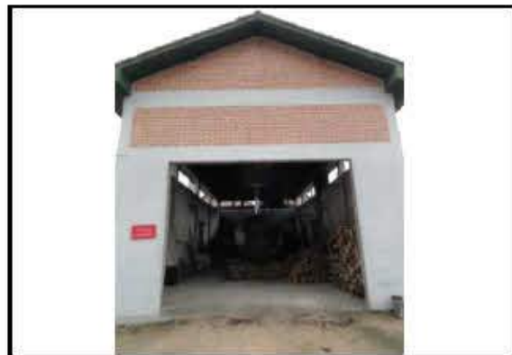
Vista da casa da caldeira
