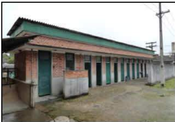
Vista do prédio de sanitários A
