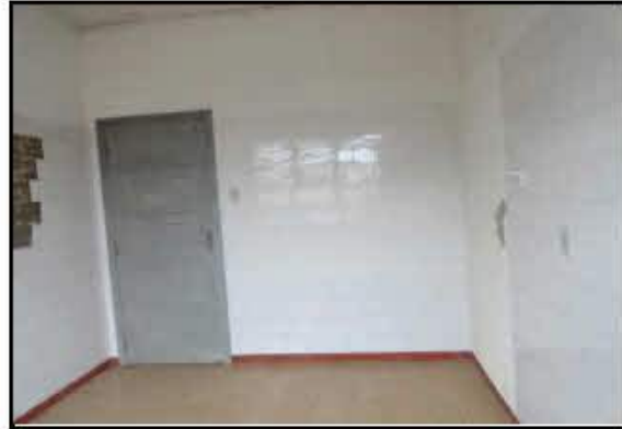
Aspecto da cozinha
