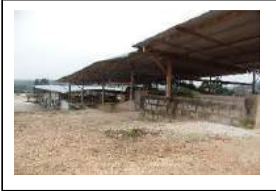
Galpão da lavagem especial
