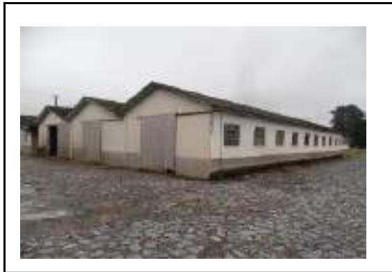
Galpão da manutenção
