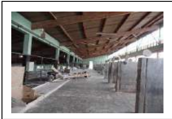
Área de preparação da mistura de agregados
