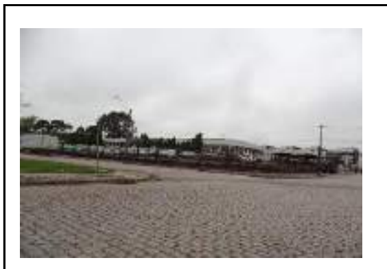
Frente do imóvel para Av. Porcelana
