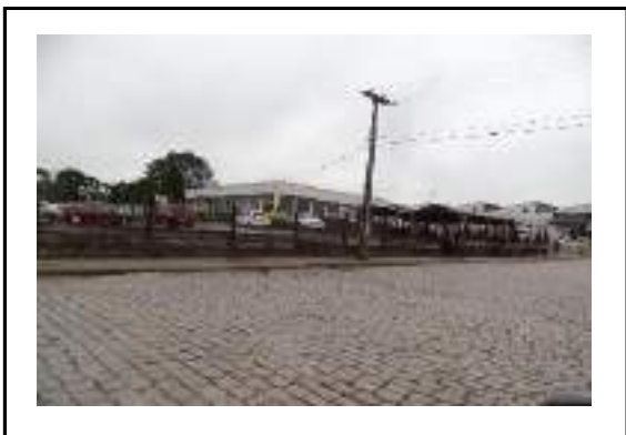
Frente do imóvel para Av. Porcelana
