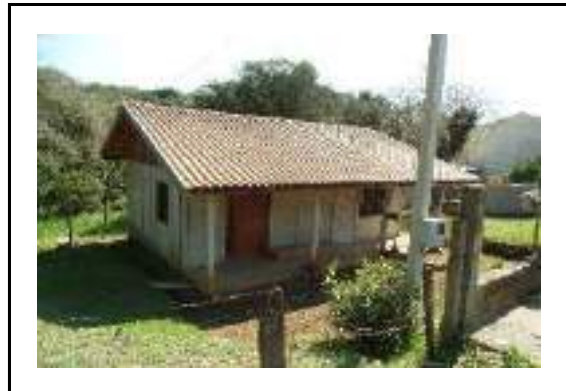
Detalhe da casa do lado direito que ocupa a área
