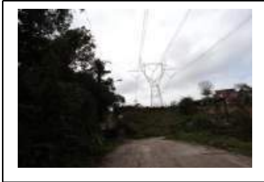
Estrada do Sumaré
