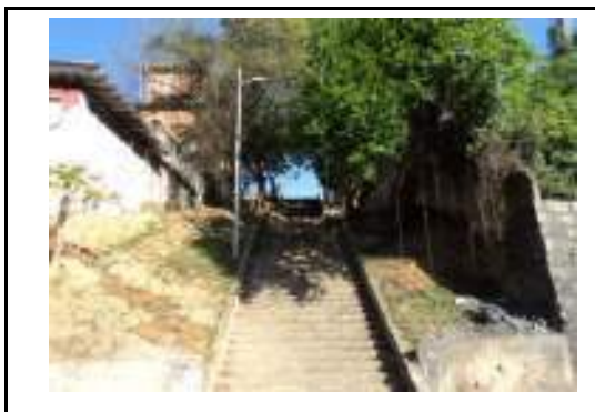
Escada na lateral esquerda
