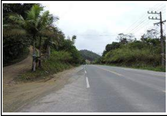
Aspecto da Rodovia Guilherme Jensem-SC 108 com imóvel de ambos os lados
