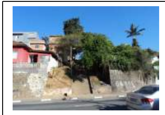
Escada na lateral esquerda
