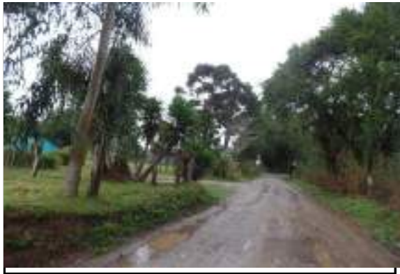
Detalhe da Estrada Sabina Risita
