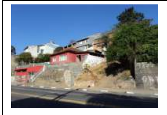
Imóvel vizinho do lado esquerdo após escada
