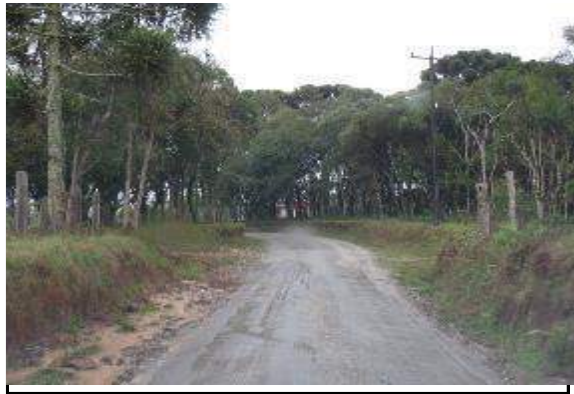
Detalhe da Estrada Sabina Risita
