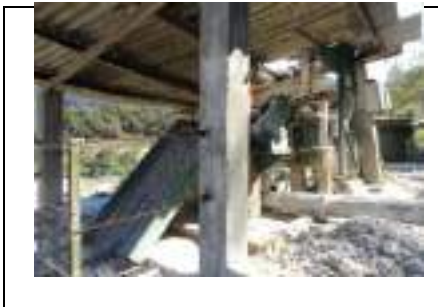
Estação de Tratamento de Efluentes
