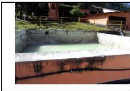
Processo de reciclagem de água
