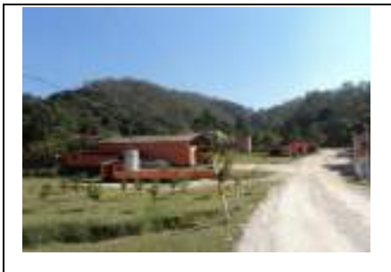
Edificações de apoio
