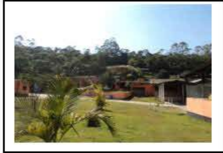
Edificações de apoio
