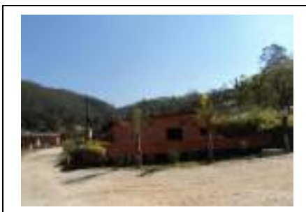
Edificações de apoio
