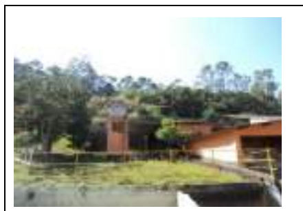
Processo de reciclagem de água
