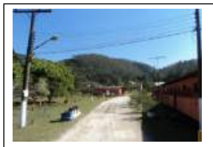
Edificações de apoio
