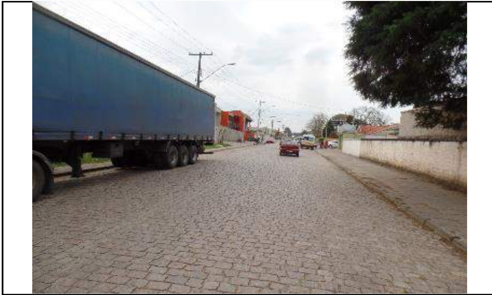
Rua Porcelana, sentido norte, com o imóvel à esquerda
