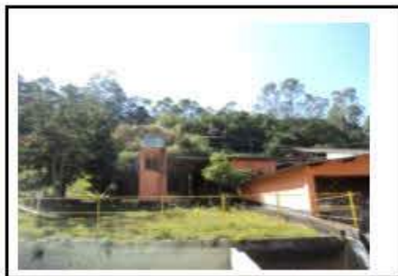
Processo de reciclagem de água
