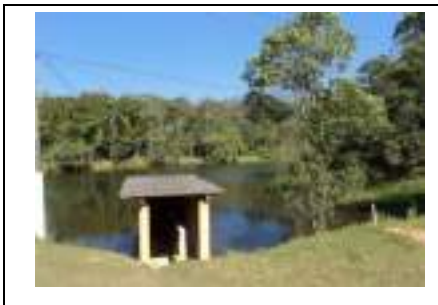
Represa de captação de água
