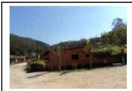
Edificações de apoio
