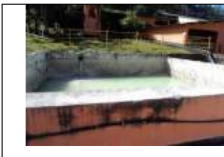
Processo de reciclagem de água
