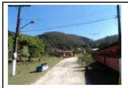
Edificações de apoio
