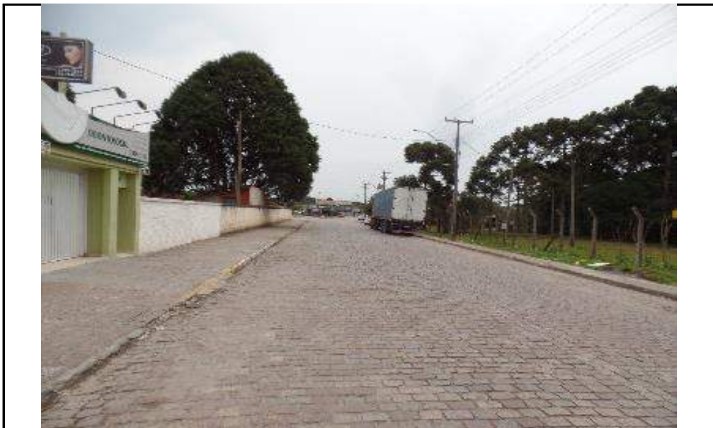
Rua Porcelana, sentido sul, com o imóvel à direita
