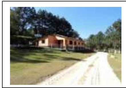
Edificações de apoio
