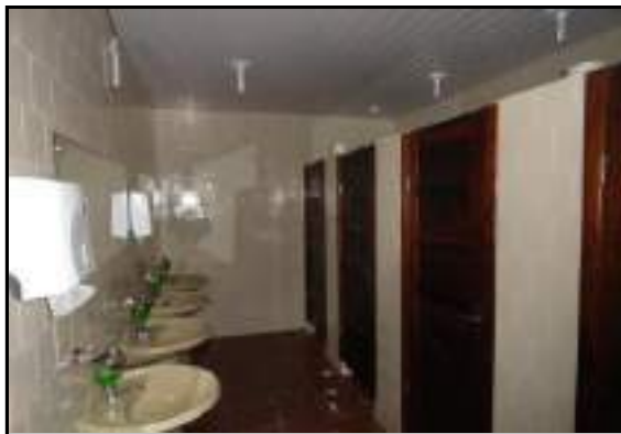
Detalhe de sanitário
