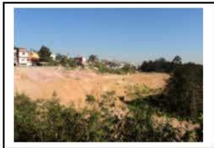
Obras emergenciais de Contenção
