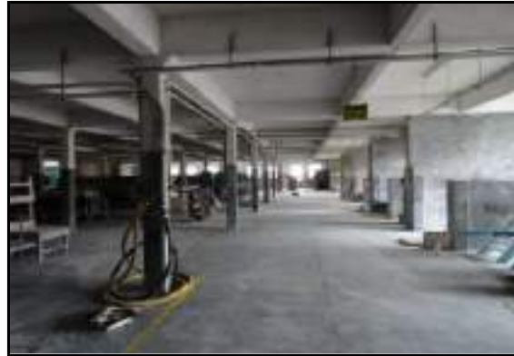
Pavimento térreo do galpão de decalque
