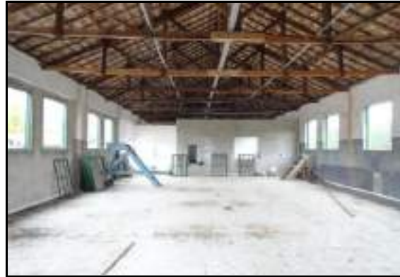
Vista de futuro refeitório
