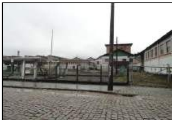
Fachada para a Av. 21 de Janeiro
