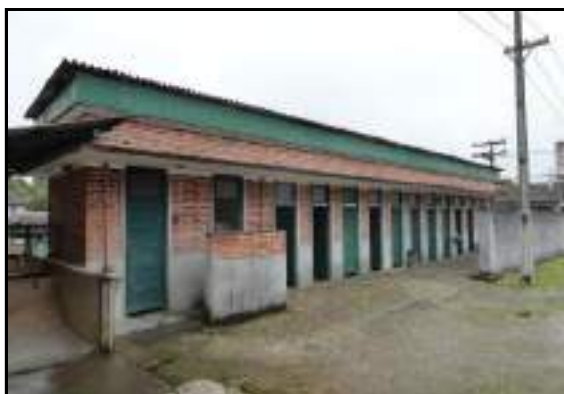
Vista do prédio de sanitários A
