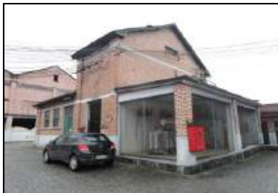
Aspecto da subestação
