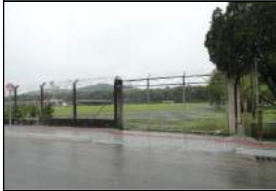
Vista frontal do imóvel
