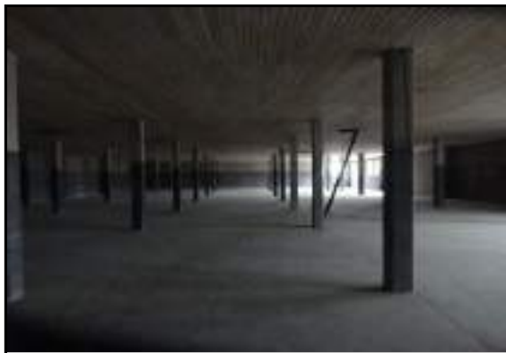
Vista do pavimento superior
