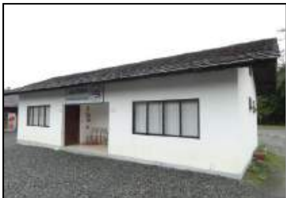
Vista do prédio de auditório
