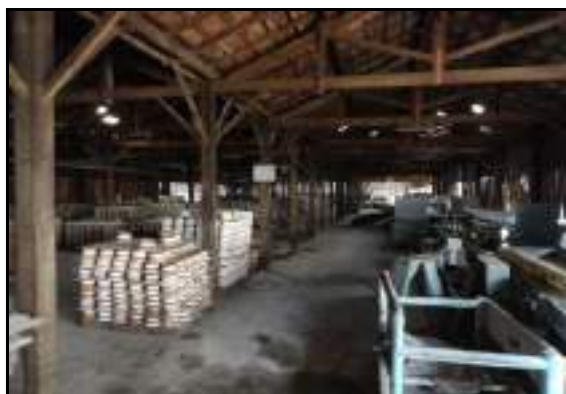
Vista interna de galpão de madeira
