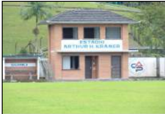
Cabine de comando do campo
