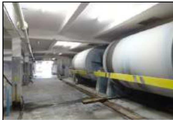
Detalhe do subsolo do galpão de decalque
