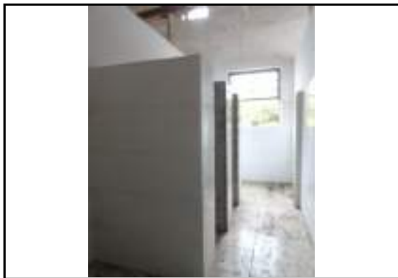
Vista de futuros sanitários
