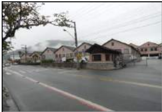
Vista frontal do imóvel
