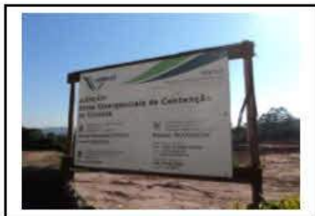
Obras Emergenciais de Contenção de Encosta
