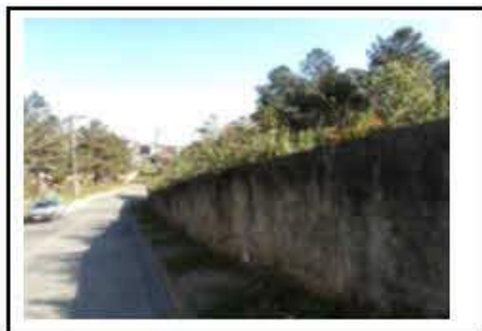
Muro de divisa
