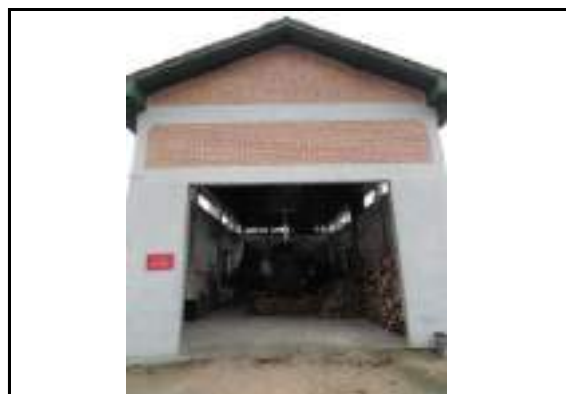
Vista da casa da caldeira
