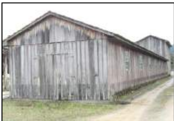
Vista de galpão de madeira
