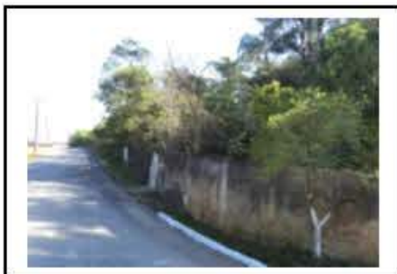
Muro de divisa
