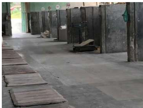
Baias de estocagem de matéria prima
