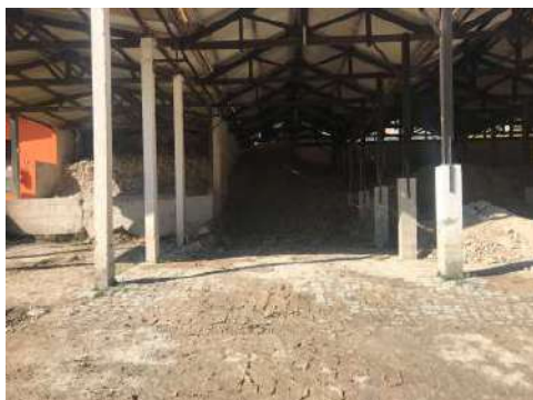
Depósito de caulim para utilização
