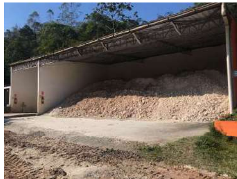
Depósito de caulim para utilização
