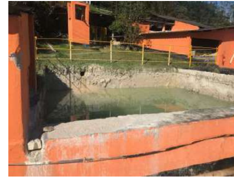
Tanque de agua tratada após o processo de separação
