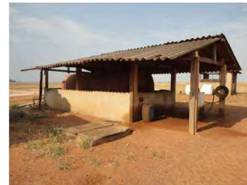
Tanque de diesel
