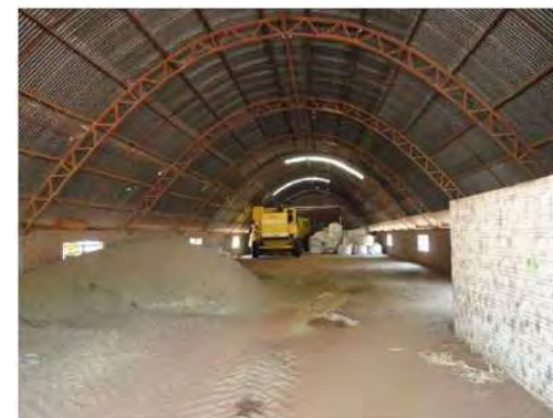
Foto interna do barracão
