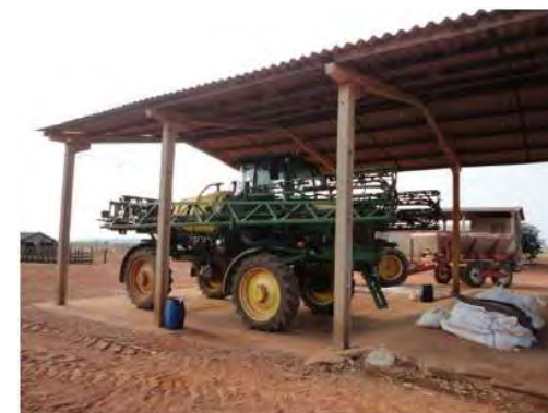
Barracão para guardar maquinário
