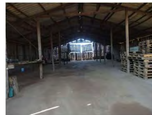
Foto interna do barracão
