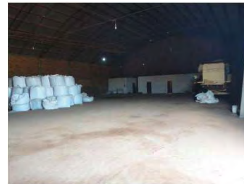
Foto interna do barracão
