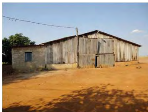
Barracão fechado de madeira
