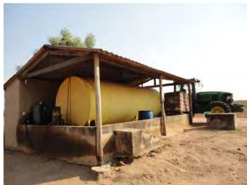
Tanque de diesel
