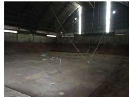
Foto interna do armazém graneleiro
