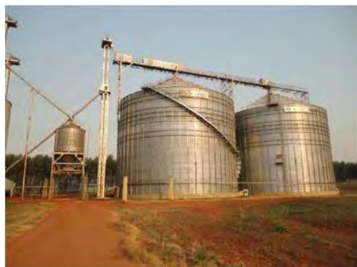
Silos e caixa de expedição
