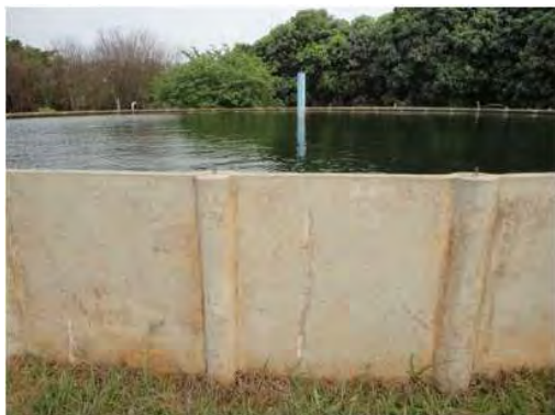
Reservatório de água
