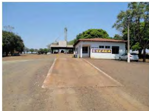
Estrutura física da unidade
