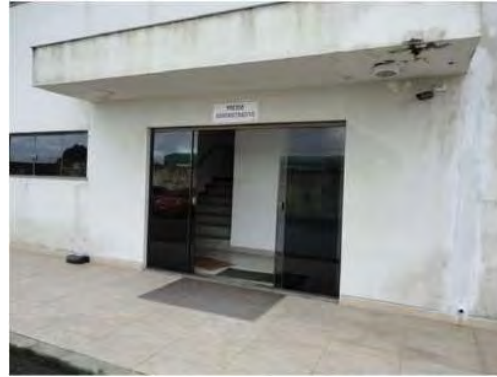
Escritório Administrativo do Terminal Portuário Seara S.A.
