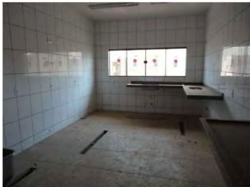
Foto interna do refeitório – obra inacabada
