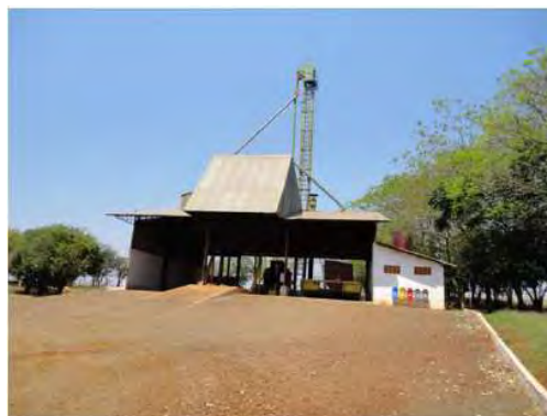
Estrutura da unidade de transbordo
