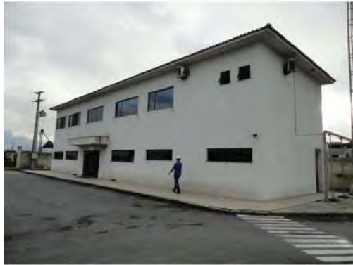
Escritório Administrativo do Terminal Portuário Seara S.A.
