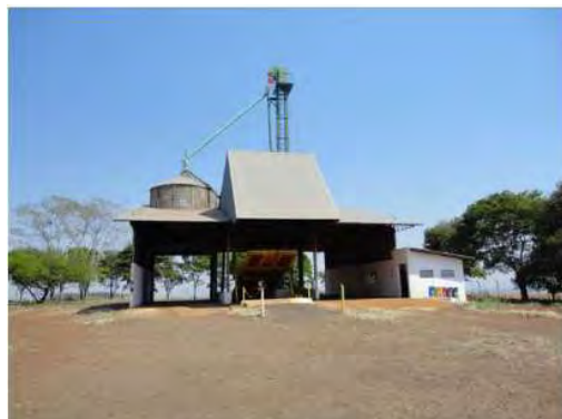
Estrutura da unidade de transbordo
