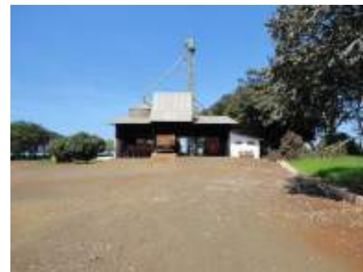
Estrutura da unidade de transbordo
