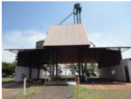
Estrutura da unidade de transbordo
