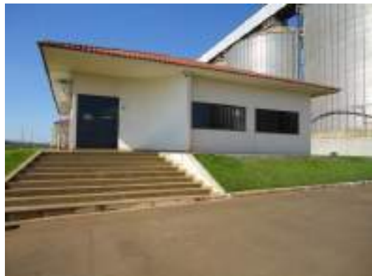
Escritório do Terminal Maringá onde a Seara ocupa uma sala
