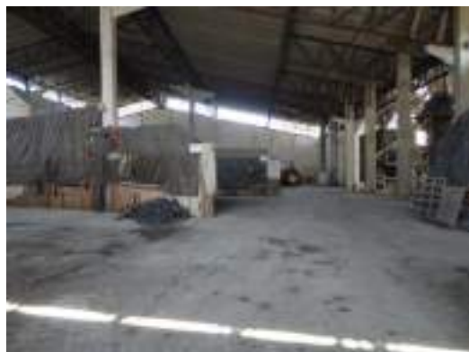
Foto interna da misturadora
