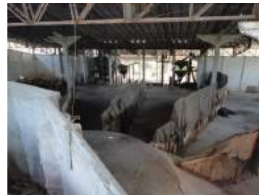
Foto interna da misturadora
