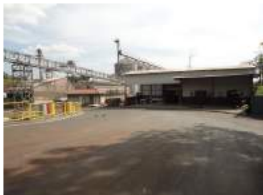
Oficina de manutenção
