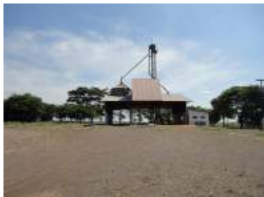
Estrutura da unidade de transbordo
