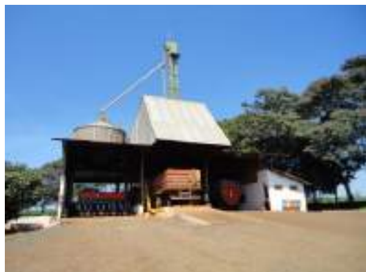
Estrutura da unidade de transbordo
