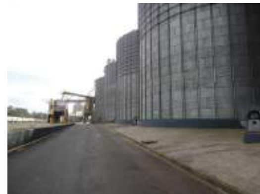
Pátio e silos de armazenagem
