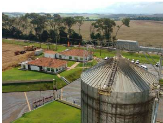
Vista panorâmica do pátio de manobras, silos e escritório.
