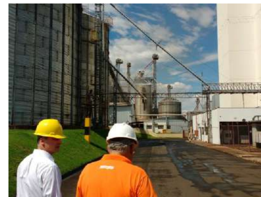
Silos de Estocagem (esquerda) e Unidade de Processamento de Milho (direita)
