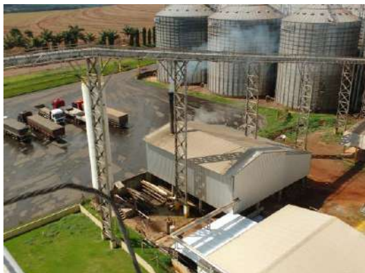
Vista panorâmica do estacionamento e pátio de manobras e casa de caldeira
