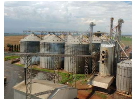
Vista panorâmica dos silos de armazenagem, moega, secador e elevadores.
