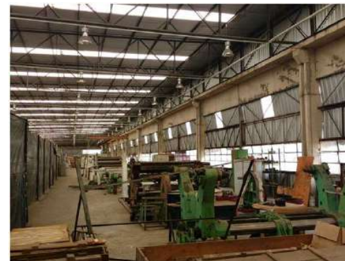
Projeto de corrugados (inoperante)
