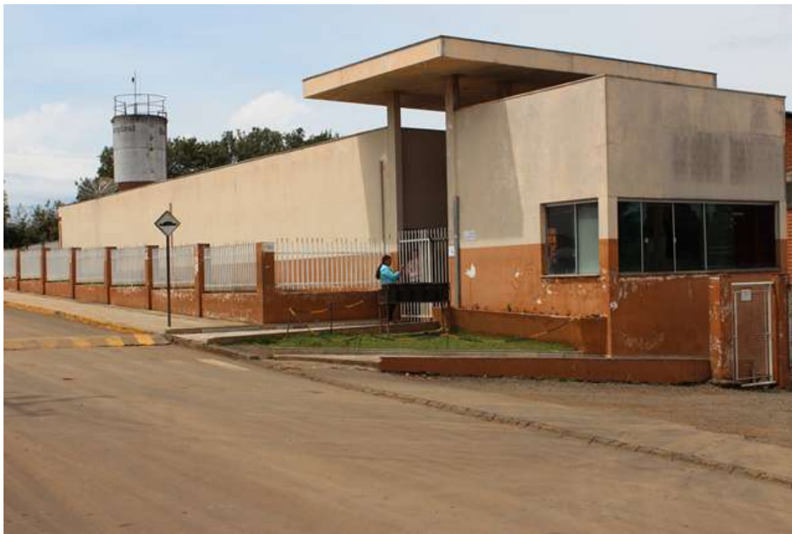
Foto 17 – Frente do imóvel. Guarita
