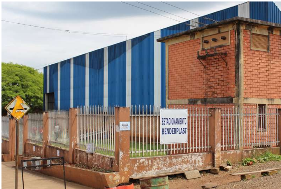
Foto 1 – Frente do imóvel.
