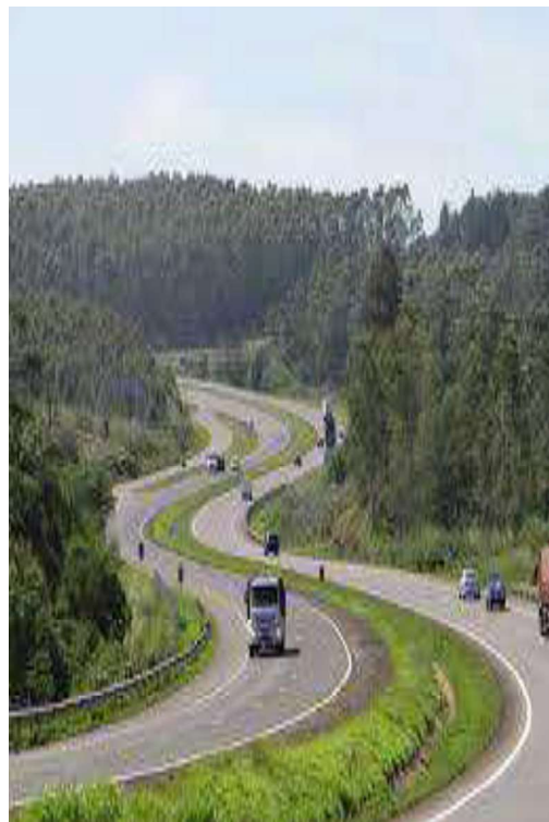
Fonte: Rede Social da Contratante. Execução da Duplicação da BR 386 RS - Trecho Estrela /Tabaí
