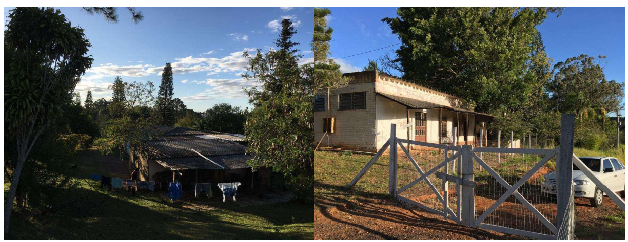
Fonte: Wert Engenharia
