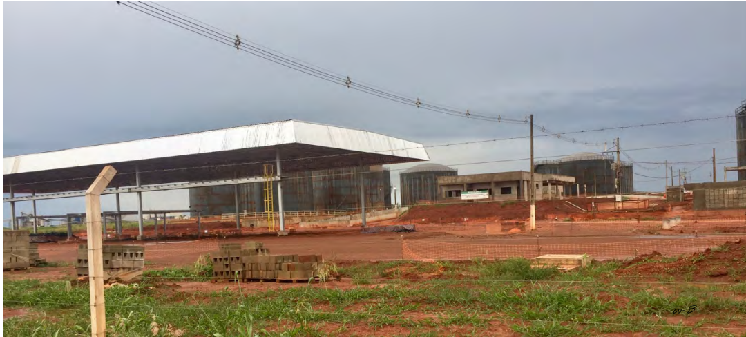
Figura 23- Rua A – A principal, Terminal de combustível- PETROBRAS
