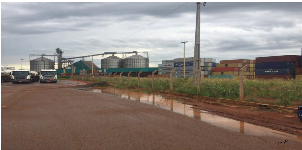
Figura 18- Rua A – A principal, Terminal de Contêiner – Brado Logística. Unidade de grãos
