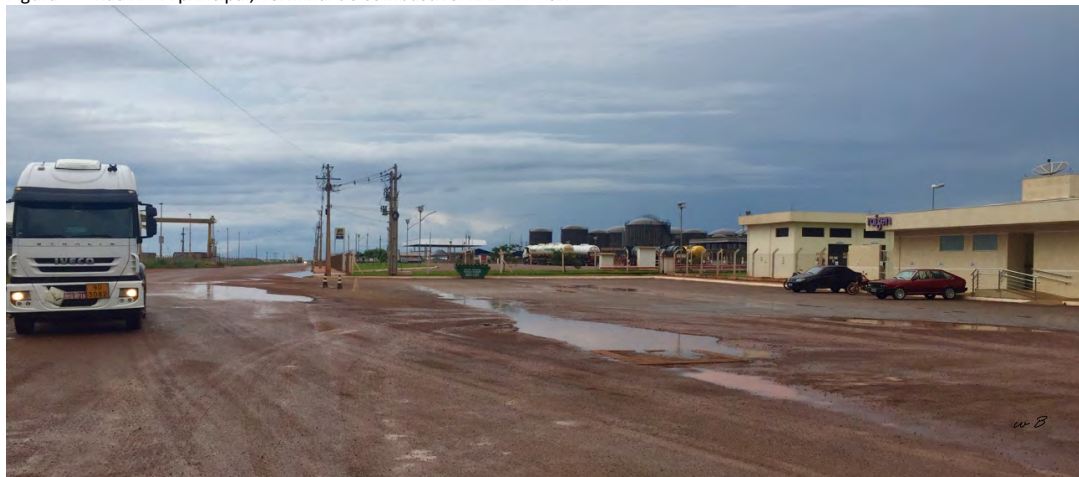
Figura 22- Rua A – A principal, Terminal de combustível RAÍZEN – SHEELL
