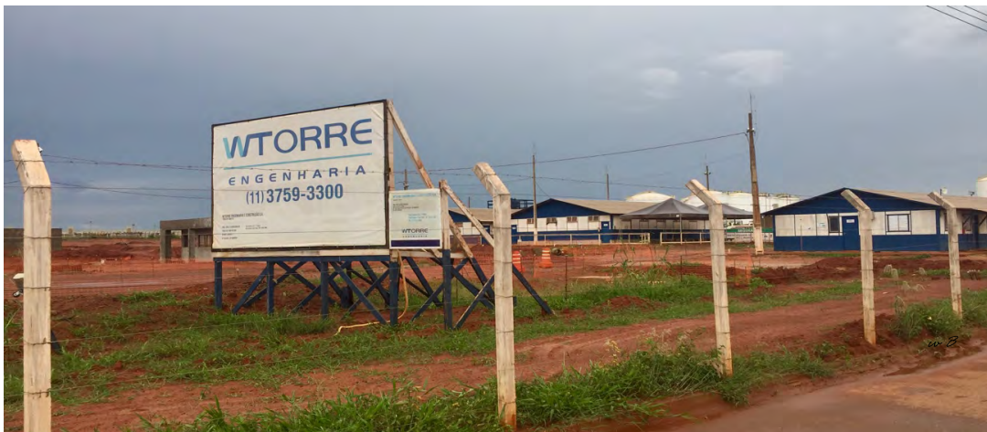
Figura 24- Rua A – A principal, Terminal de combustível- PETROBRAS
