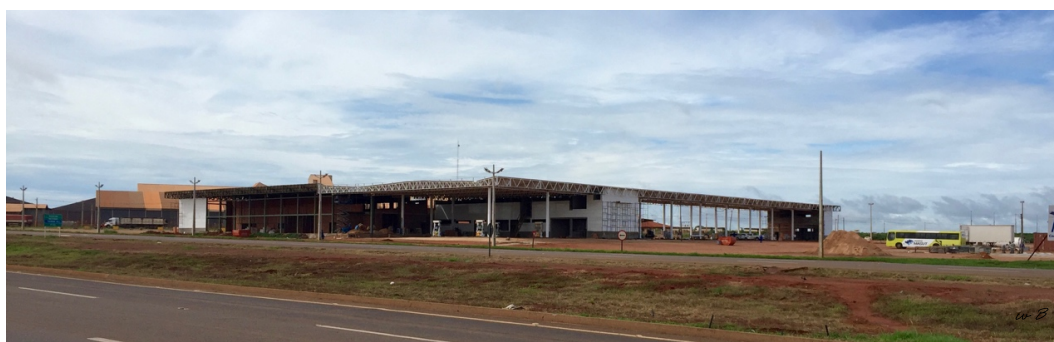
Figura 4 –Auto Posto na entrada do terminal, em construção.
