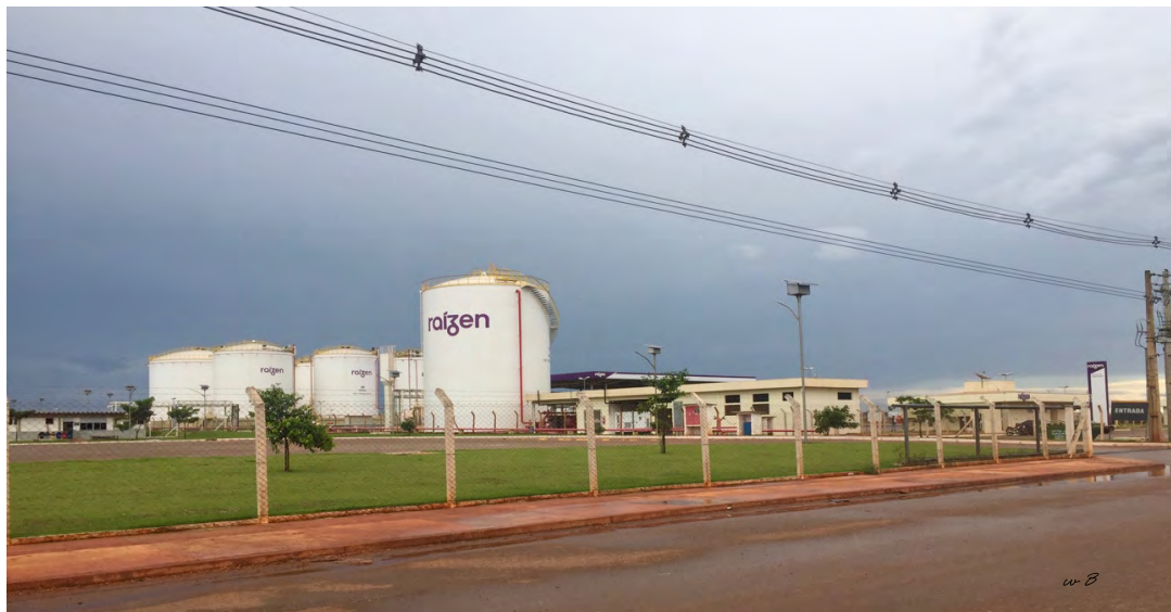
Figura 20- Rua A – A principal, Terminal de combustível RAÍZEN – SHEELL
