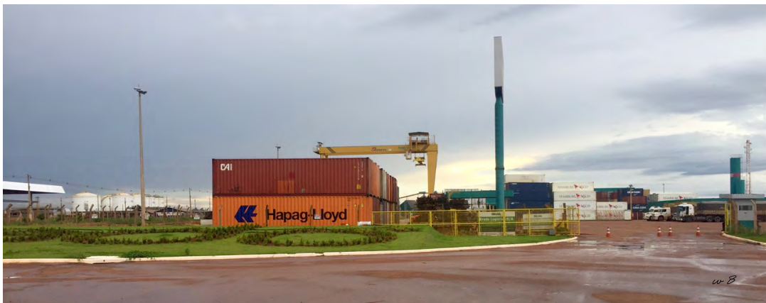
Figura 15 - Rua A – A principal, Terminal de Contêiner – Brado Logística.
