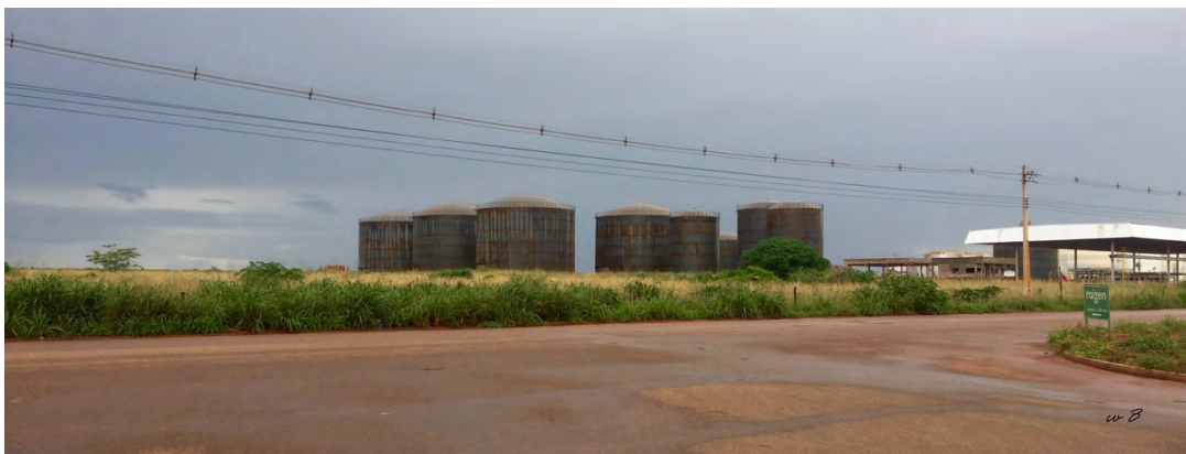
Figura 15 - Rua A – A principal do Terminal de combustíveis Petrobras em obras. Vizinho do lote avaliado
