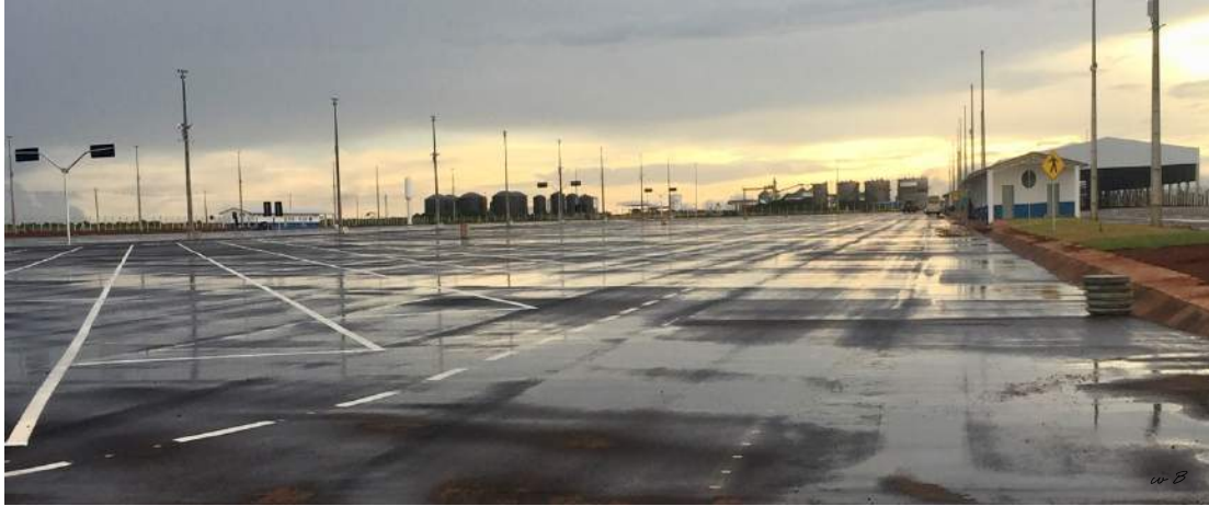
Figura 4 Pátio de estacionamento
