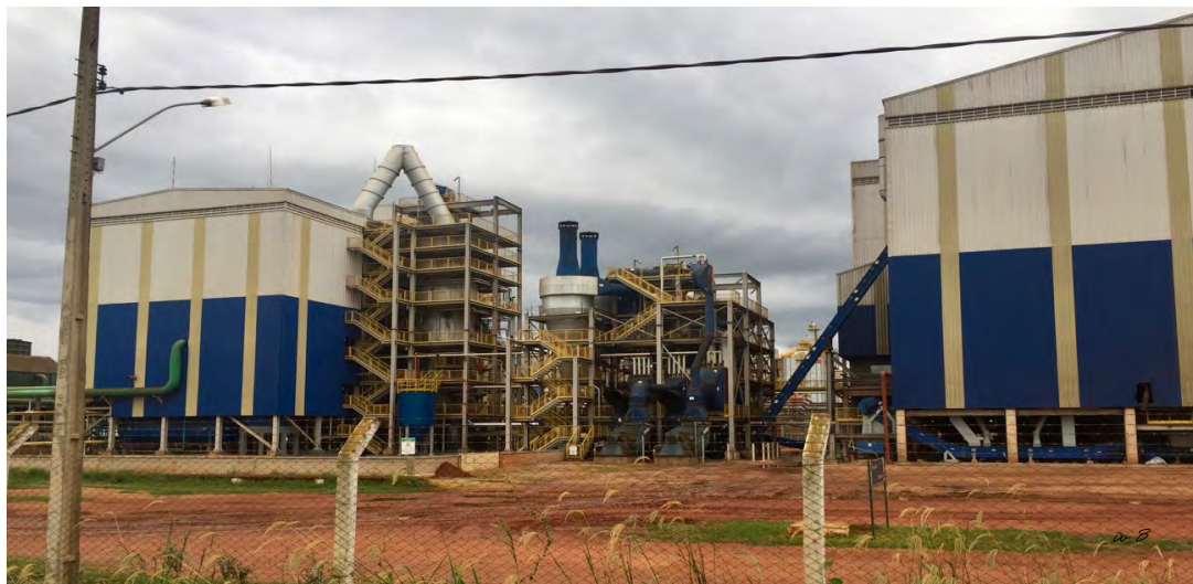
Figura 27- Rua B - Marginal frente pra BR 163 - RUMO -ALL - armazenagem e moagem
