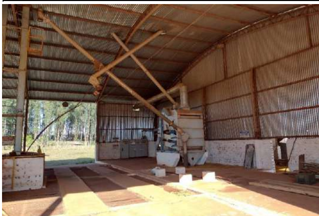
Interior do Galpão
