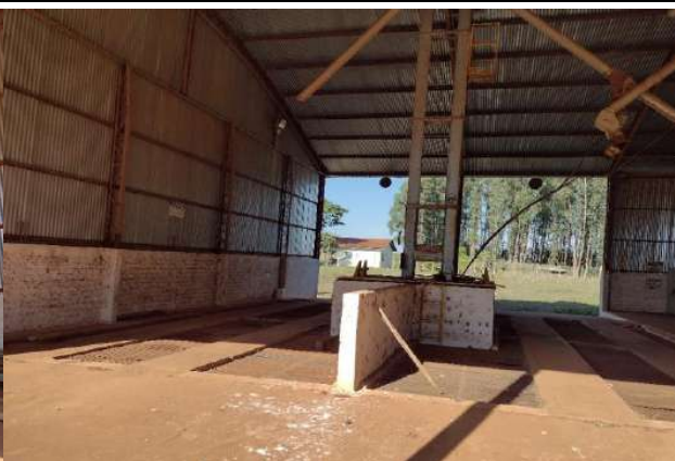
Interior do Galpão
