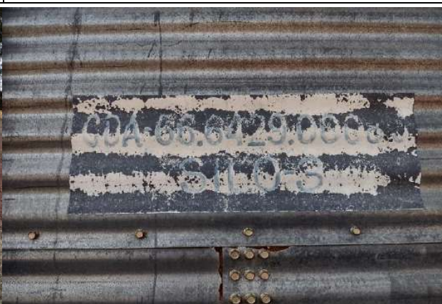
Descrição do Silo
