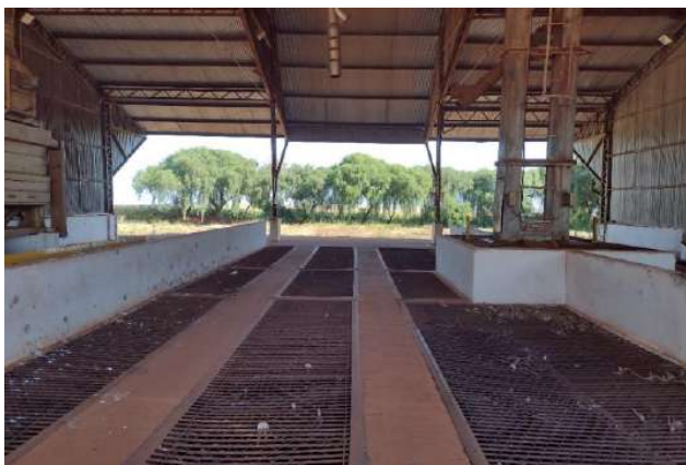
Interior do Galpão
