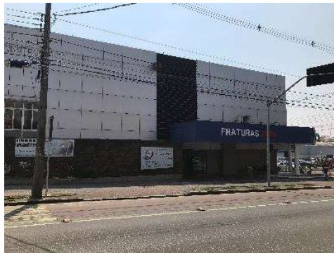
Fachada Vista Geral
