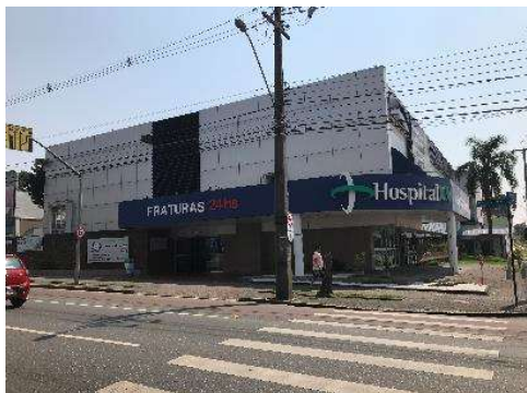
Fachada Vista Geral
