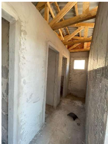
Figura 43 - Vista geral interna - Banheiros e Vestiários
