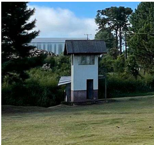
Figura 41 - Vista geral - Guarita
