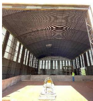
Figura 22 - Vista geral interna barracão caldeira
