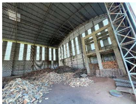
Figura 24 - Vista interna barracão caldeira
