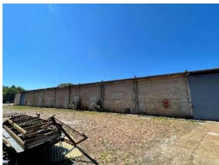
Figura 44 - Vista externa - Barracão depósito
