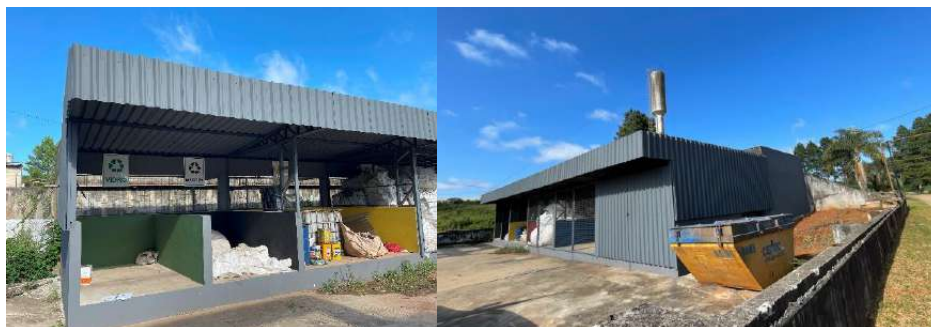
Figura 49 - Vista geral - baias de resíduo reciclável
