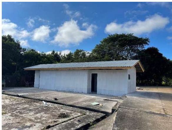
Figura 42 - Vista geral externa - Banheiros e Vestiários
