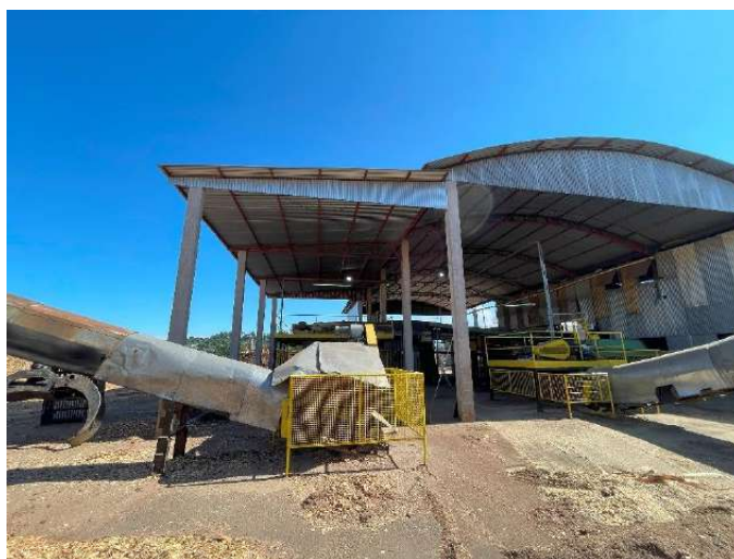
Figura 47 - Vista geral - Barracão abrigo das serras
