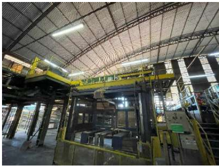
Figura 28 - Vista interna - Compensado 3
