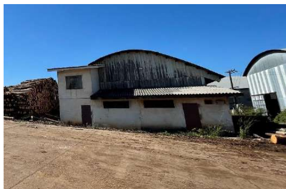
Figura 20 - Edificação anexa a serraria
