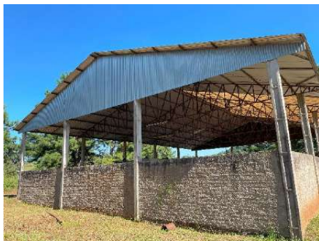
Figura 14 - Vista externa ETA 1
