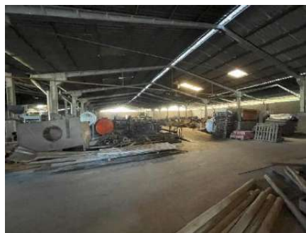
Figura 45 - Vista interna - Barracão depósito
